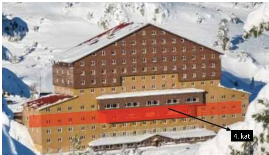
Fotoğraf 3 - Otelin arka cephe görünümü ve yangının başlangıç yeri
