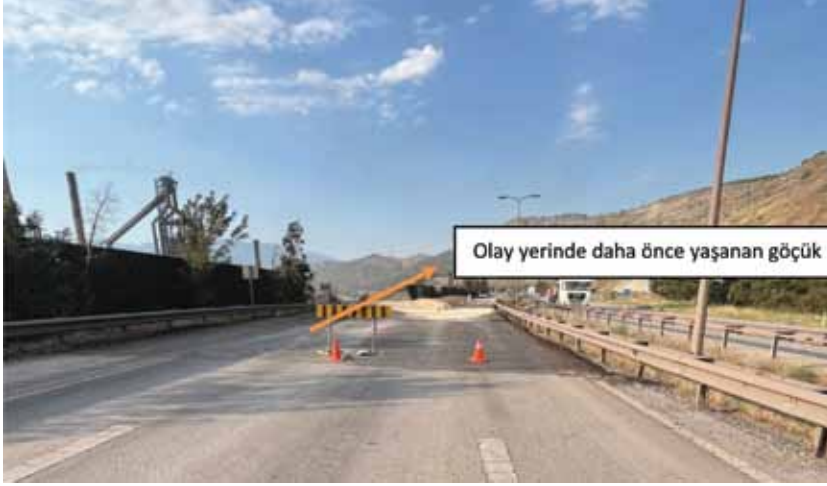
Fotoğraf 5 - Göçmenin yaşandığı bölgedeki yüzeysel tamiratlar
