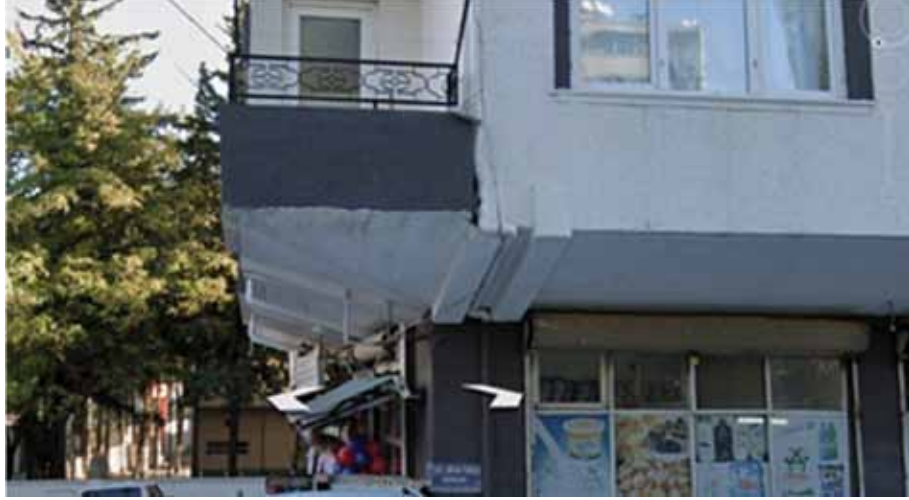
Fotoğraf 1 - Kapalı çıkmada konsol ve alın kirişlerinin yapılmadığı (veya kaldırıldığı), zemin kattaki tüm duvarların market tarafından kaldırıldığı bina örneği.
