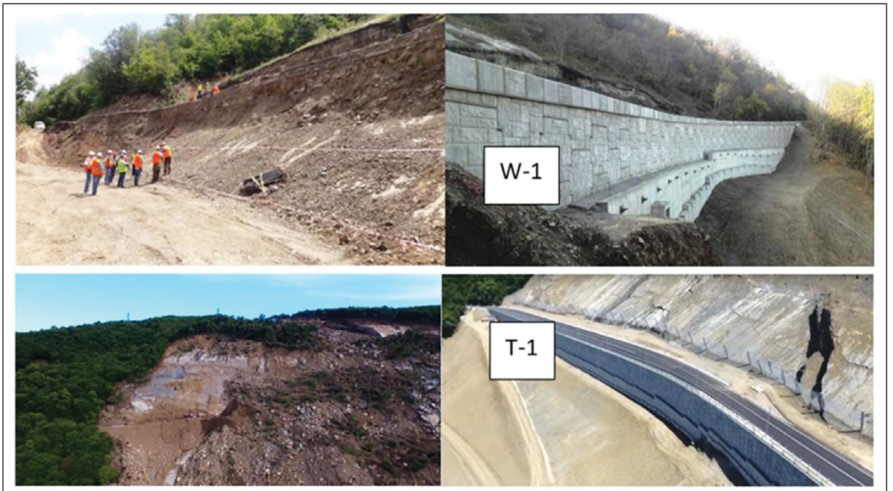
Şekil 7 - W-1 ve T-1 rehabilitasyon kesiti
