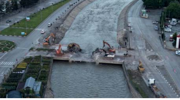
Resim 3 - ÇEDAŞ köprüsünün yıkımı
