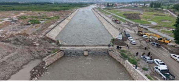
Resim 4 - Yenisanayi Köprüsü'nün yıkımı
