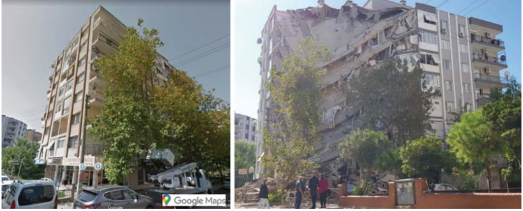
Şekil 10 - Karagül Apartmanı'nın deprem öncesi (Google Maps, 2020) ve sonrasındaki görünümü
