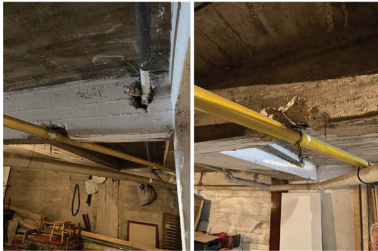
Şekil 31 - Kullanım aşamasında kirişe verilen hasarlar (Karşıyaka, İzmir)
