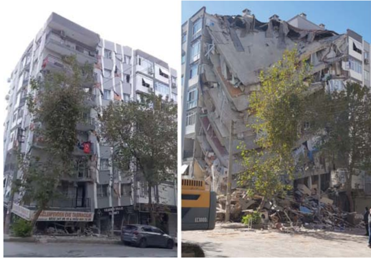
Şekil 26 - Karagül Apartmanı'nın göçme anı ve sonrası (Posta, 2020)
