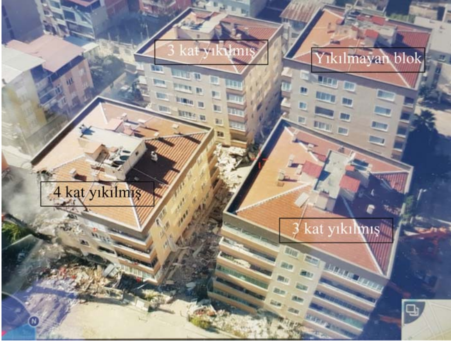
Şekil 12 - Barış Sitesi enkazı (uçangöz görünümü)
