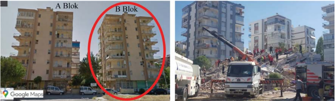
Şekil 8 - Yağcıoğlu Sitesi B Blok'un deprem öncesi (Google Maps, 2020) ve sonrasındaki görünümü
