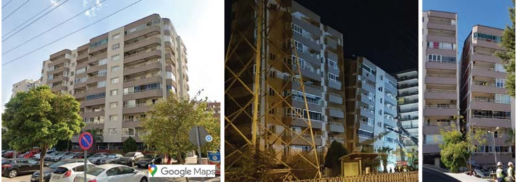
Şekil 9 - Yılmaz Erbek Apartmanı'nın deprem öncesi (Google Maps, 2020) ve sonrasındaki görünümü
