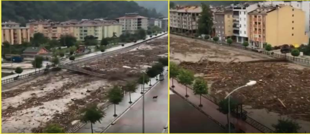
Fotoğraf 8 - Yaya Köprüsünün Taşkın Sırasında Yıkılma Anı ve Taşkın Sırasında Sürüklenmesi
