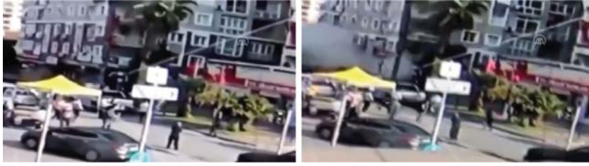
Şekil 25 - Rıza Bey Apartmanı'nın göçme anı (NTV, 2020)
