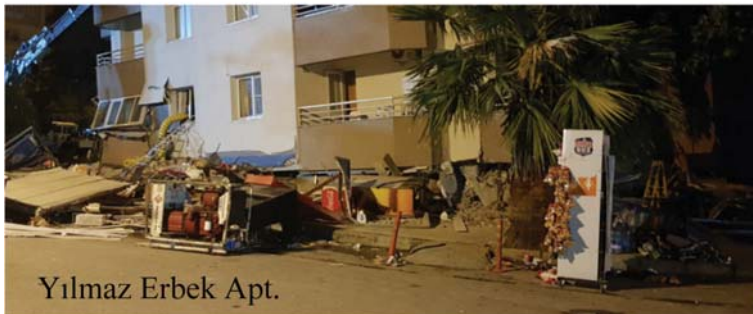
Şekil 24 - Alt katı veya alt birkaç katı göçen binalar
