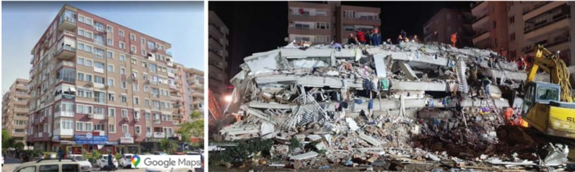
Şekil 5 - Rıza Bey Apartmanı'nın deprem öncesi (Google Maps, 2020) ve sonrasındaki görünümü
