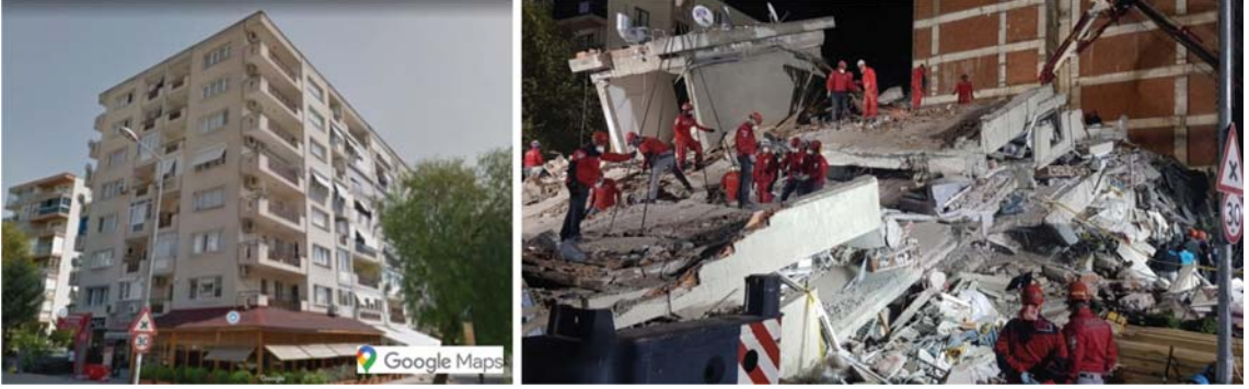
Şekil 6 - Doğanlar Apartmanı'nın deprem öncesi (Google Maps, 2020) ve sonrasındaki görünümü
