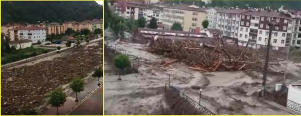
Fotoğraf 4 - Taşkın Anında Derenin Taşdığı Odunsu Nesnelere ve Köprüyü Tıkayan Ağaç, Dal ve Tomruklar
