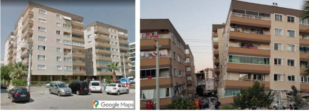
Şekil 11 - Barış Sitesi'nin deprem öncesi (Google Maps, 2020) ve sonrasındaki görünümü
