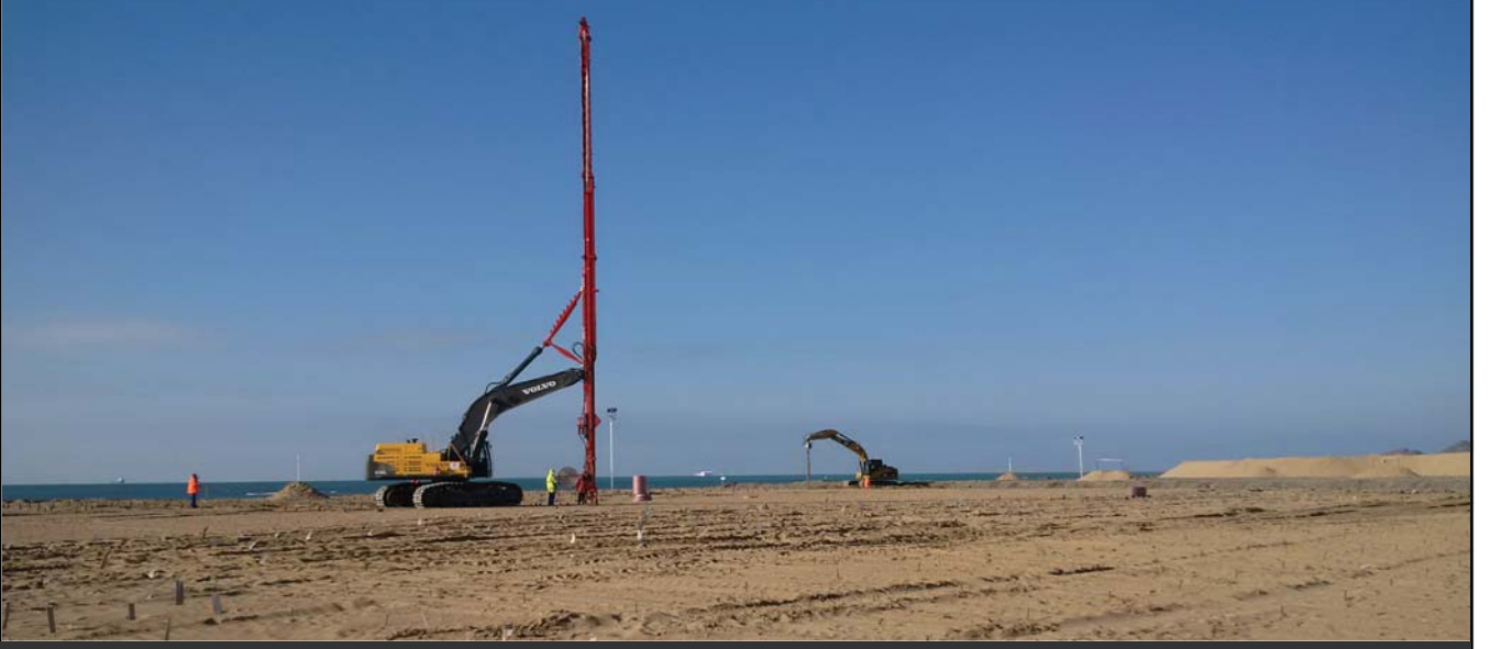
Türkmenbaşı Port, Zemin Islah İşleri, Türkmenistan
