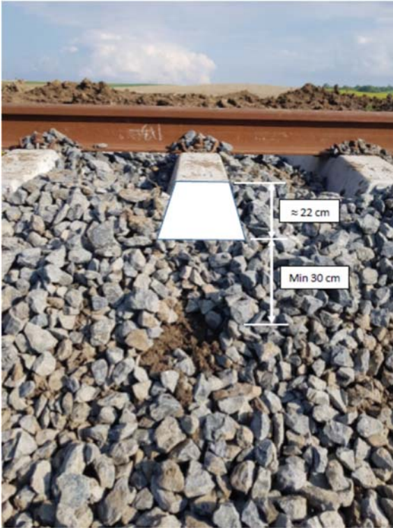
Resim 18 - Onarılan hat kesiminde balast tabakasının kalınlığı yeterli değil. Balast malzemesi zemin ile karışmış.
