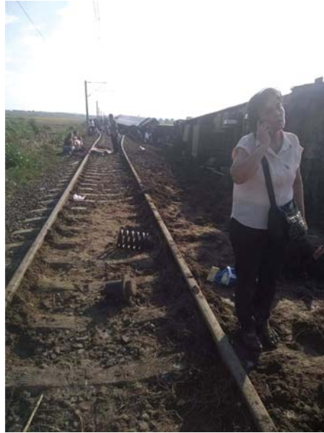
Resim 11c - Birbirinden kopan üçüncü ve dördüncü vagonların arasındaki hattın sol (kuzey) rayı traverslere bağlı şekilde ayakta duruyor.
