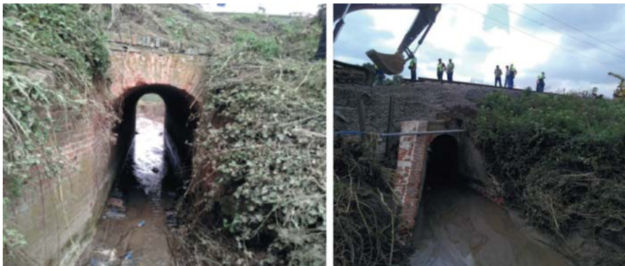
Resim 13b - Menfezin girişi (solda) ve çıkışı (sağda).
