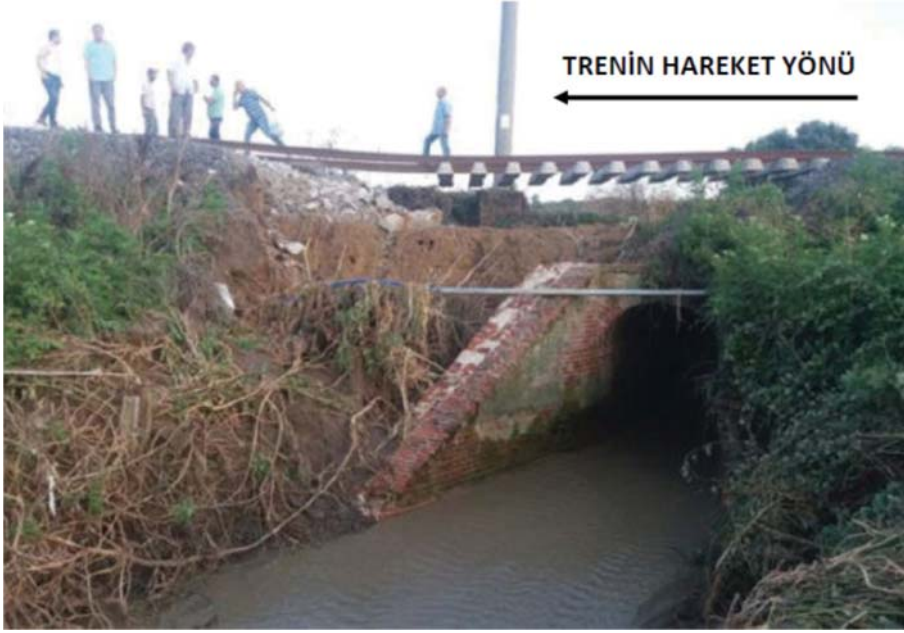
Resim 2 - Menfezin üstündeki toprak dolgu ve balast tabakası boşalmış, travers ve raylardan oluşan yol çerçevesi boşta (askıda) kalmış, beton traverslerin bir kısmı trenin geçişi sırasında zarar görmemiştir.
