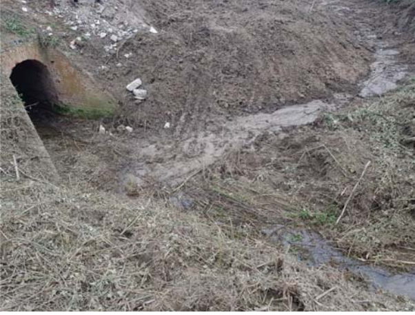
Resim 15a - Menfeze su getiren iki dereden birinin yatağı genişletilmiş ve bitkiler kısmen temizlenmiştir.
