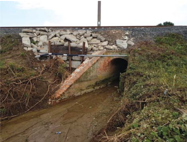
Resim 16a - Menfez dolgusunun çıkış (mansap) tarafından görünüşü. Kazık gibi çakılan çelik raylar kullanılarak dolgunun üzerine yığılan beton moloz bloklar tahkim edilmiştir.
