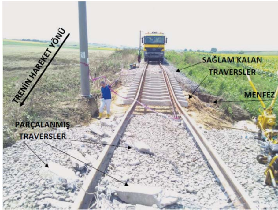
Resim 7 - Menfez bölgesinde sağlam kalan traversler ve trenin hareket yönünde parçalanmış traversler.
