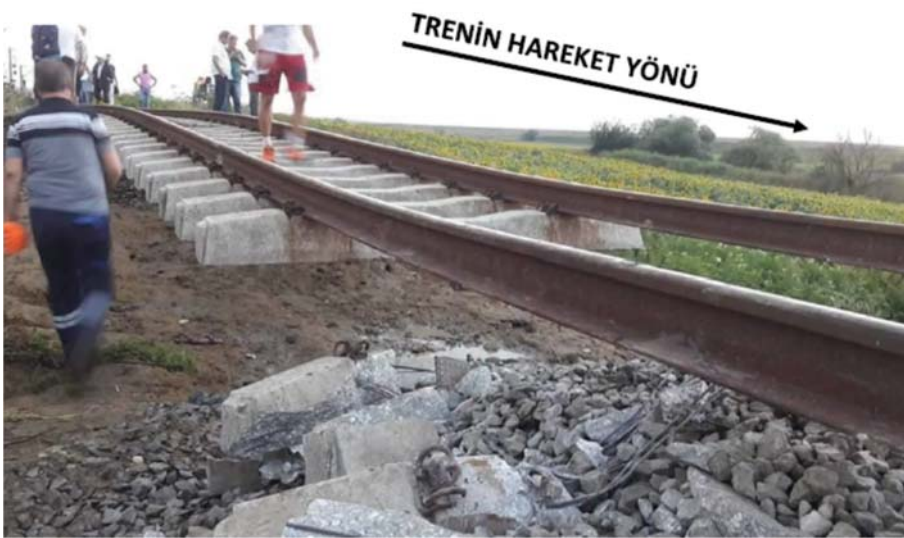
Resim 3 - Trenin hareket yönünde menfezden hemen sonra rayların altındaki traverslerin bir kısmı ezilip parçalanmış ve rayların altındaki boşluğa yığılmıştır.
