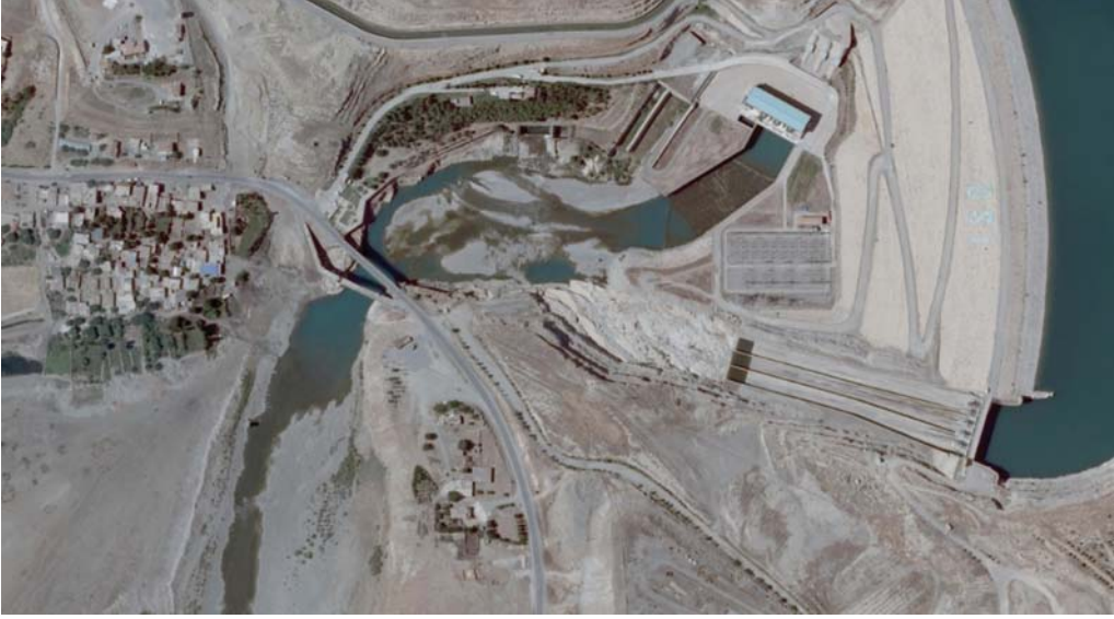
Şekil 1 - Malabadi Köprüsü'nün Konumu ( Diyarbakir Tarım İl Müdürlüğü, 2010)
