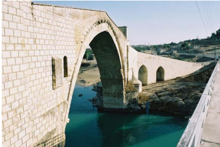
Şekil 5 - Malabadi Köprüsü Mansap Yüzü 2014 Restorasyon Öncesi
