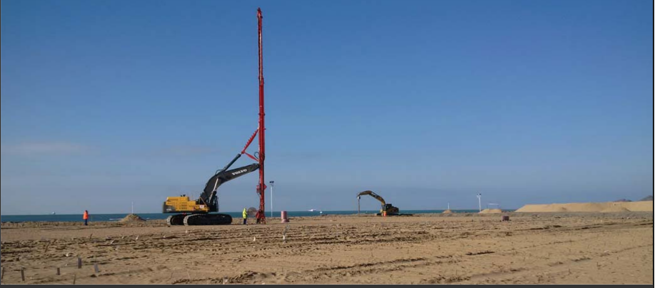
Türkmenbaşı Port, Zemin Islah İşleri, Türkmenistan
