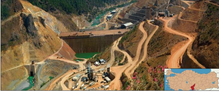
Şekil 8 - Köprü Barajı Yapım Aşaması ('Google' görselleri)
