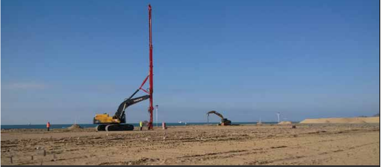
Türkmenbaşı Port, Zemin Islah İşleri, Türkmenistan
