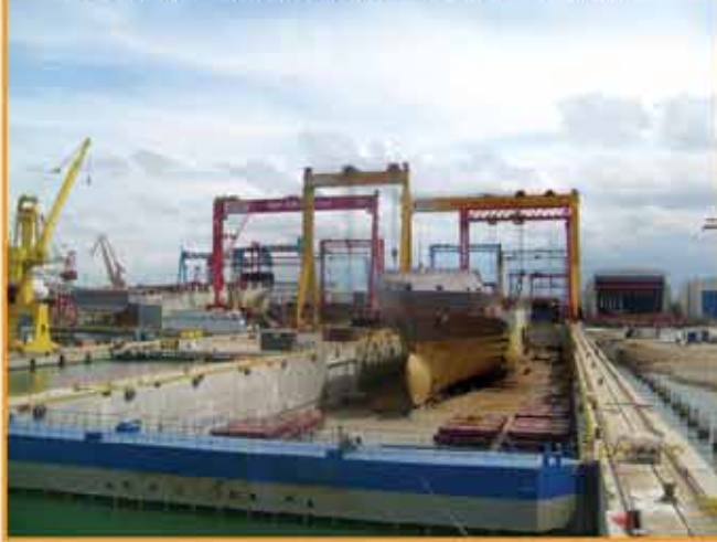
SEDEF GEMİ İNŞAATI A.Ş. / KURU HAVUZ İNŞAATI
