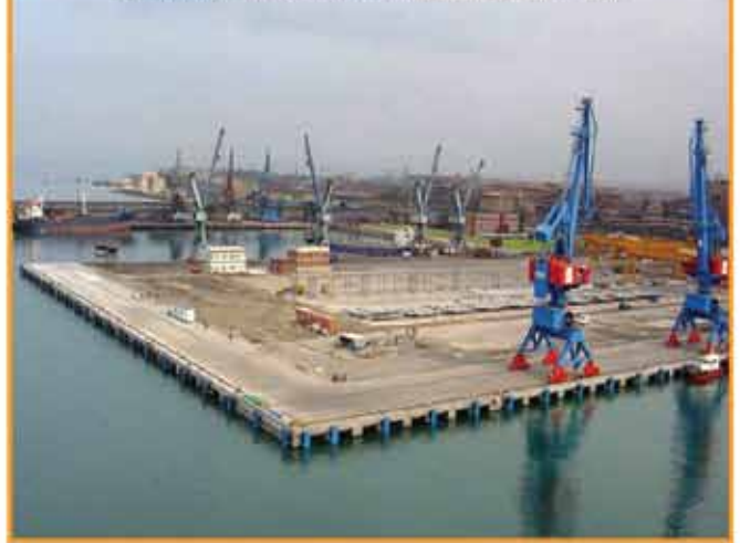
İSDEMİR / LİMAN MODERNİZASYON PROJESİ
