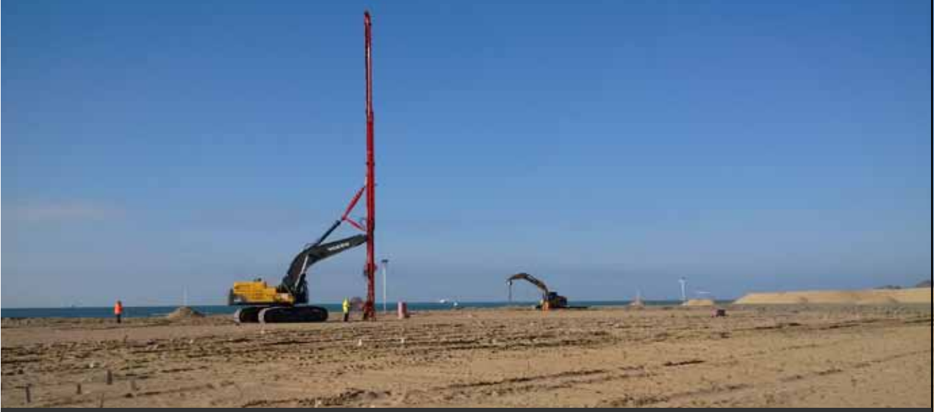
Türkmenbaşı Port, Zemin Islah İşleri, Türkmenistan
