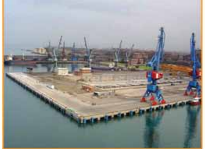
İSDEMİR / LİMAN MODERNİZASYON PROJESİ
