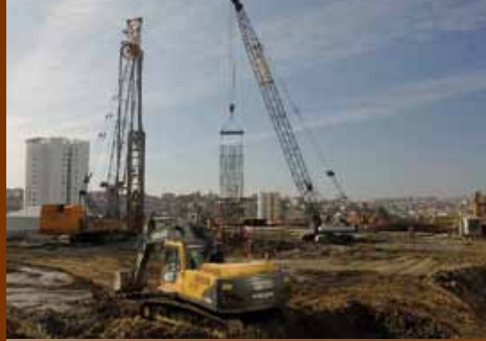
Ülker Arena Baret Temelleri, Ataşehir - İstanbul
