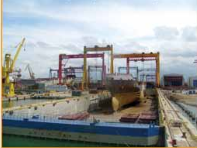
SEDEF GEMİ İNŞAATI A.Ş. / KURU HAVUZ İNŞAATI
