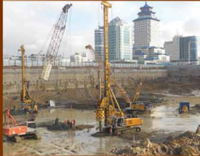
Abu Dhabi Plaza Astana İksa Sistemleri ve Fore Kazıklı Temeller, Astana - Kazakistan
