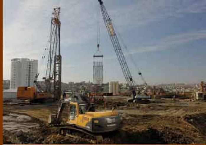
Ülker Arena Baret Temelleri, Ataşehir - İstanbul
