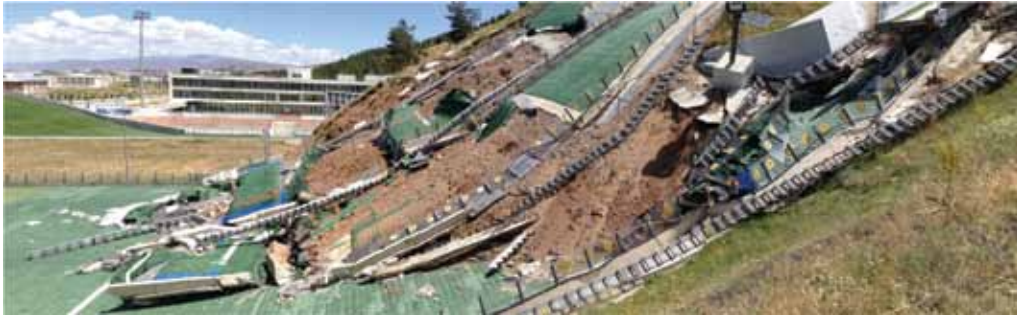
Şekil 6 - Zemin üzerine yerleştirilen 40 cm kalınlığında beton iniş rampası
