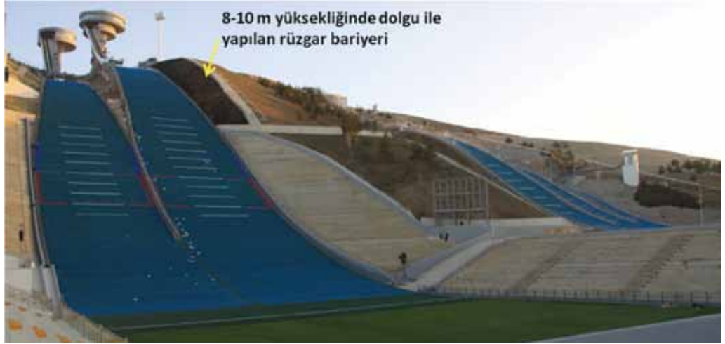
Şekil 8 - Heyelan olmadan önceki zamanlardan bir görüntü. İniş rampalarının sağ tarafında rüzgârı kesmek için kahverengi dolgu toprak yığılarak oluşturulan rüzgâr bariyeri görülmektedir.
