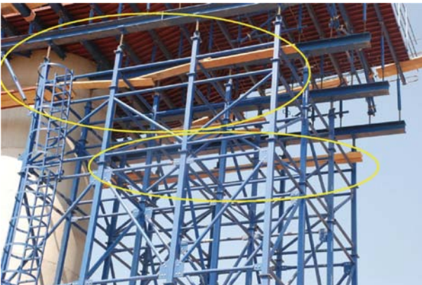
Resim 8 - İskele üzerine serbest yerleştirilmiş kaleşlar
