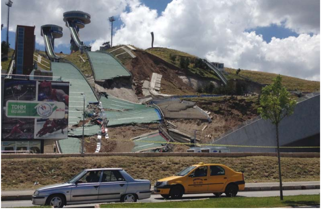
Şekil 2 - Heyelan sonrası iniş rampalarındaki hasar
