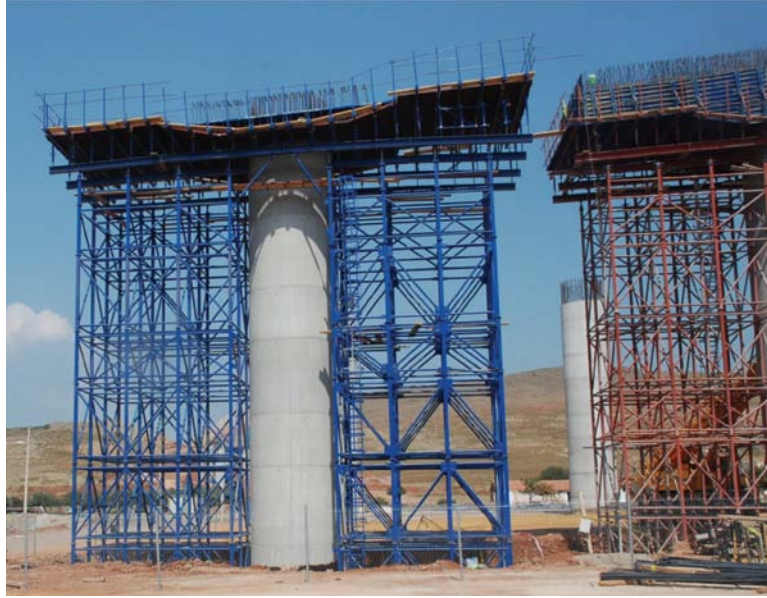
Resim 2 - Çöken Viyadük ayağının yanındaki iskelesi tamamlanmış kalıp imalatı yapılan ayak
