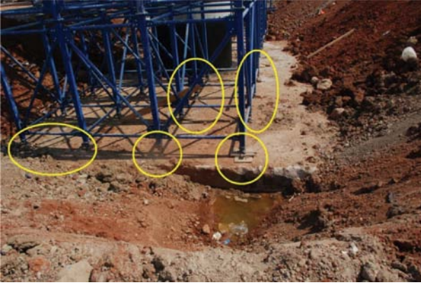
Resim 6 - İskele dikmelerinin alt uçlarında kullanılan ahşap takoz ve kamalar
