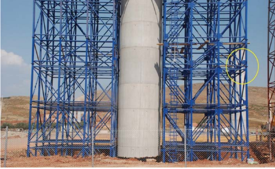
Resim 5 - Bulonlu birleşimde eleman bağlantıları sağlanmamış bitişik ayak iskele kurulumu
