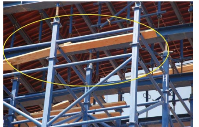
Resim 8A - İskele üzerine serbest yerleştirilmiş kaleşlar
