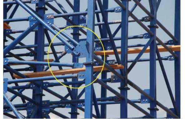
Resim 5A - Yatay ve Diagonal elemanların birleşimi yapılmamış boşta bırakılmış uçları
