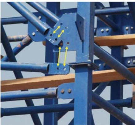
Resim 5B - Yatay ve Diagonal bağlantıları sağlanmamış bitişik ayaktaki iskele kurulumu
