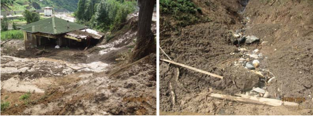
Şekil 9 - Hopa İlçesi Yoldere Köyü'nde Meydana Gelen Heyelan
