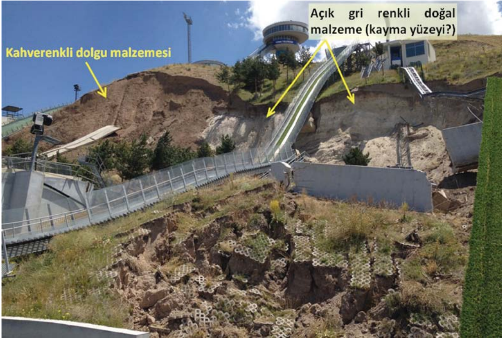
Şekil 5 - Heyelanda kahverengi dolgu malzemesi ve açık gri renkli doğal malzeme
