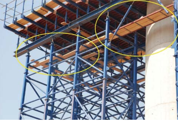
Resim 8B - İskele üzerine serbest yerleştirilmiş kalaslar
