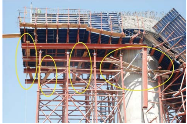
Resim 8C - İskele üzerine serbest yerleştirilmiş kalaslar
