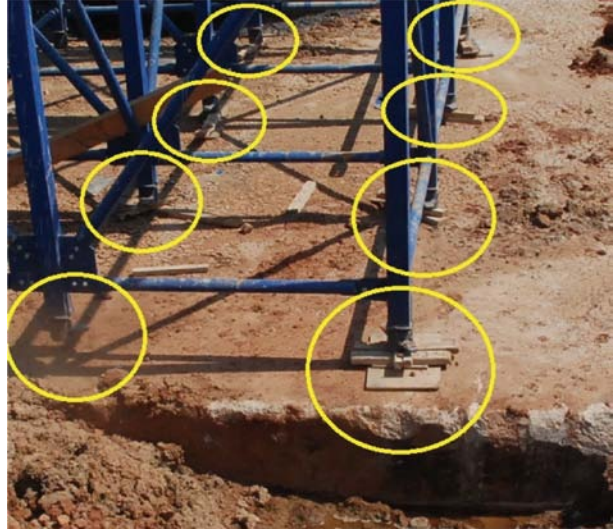
Resim 6 - İskele dikmelerinin alt uçlarında kullanılan ahşap takoz ve kamalar
