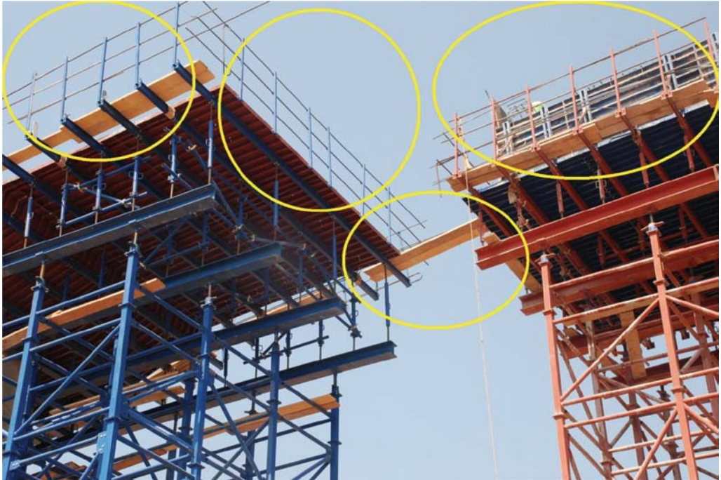
Resim 9 - Kalıp ızgara kirişleri üzerine serbest yerleştirilmiş kalaslar ve güvensiz korkuluk
