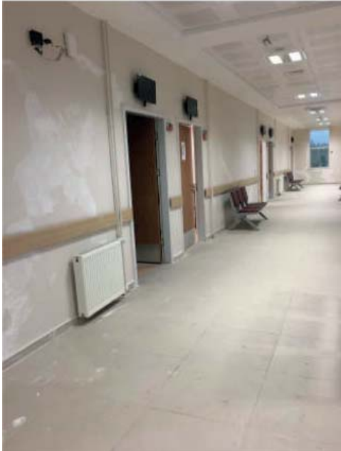
Şekil 12 - Samsat İlçe hastanesindeki yapısal olmayan hasarlar
