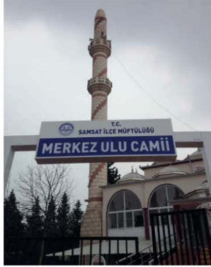
Şekil 18 - Merkez Ulu Camii minare hasarı
