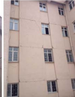
Şekil 11 - Kaymakamlık binasındaki yapısal olmayan hasarlar
