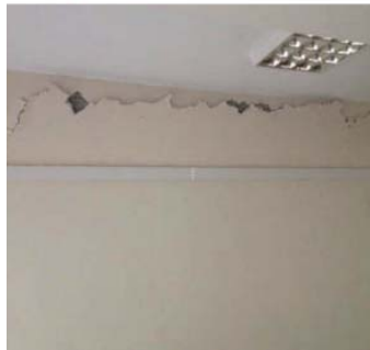
Şekil 11 - Kaymakamlık binasındaki yapısal olmayan hasarlar
