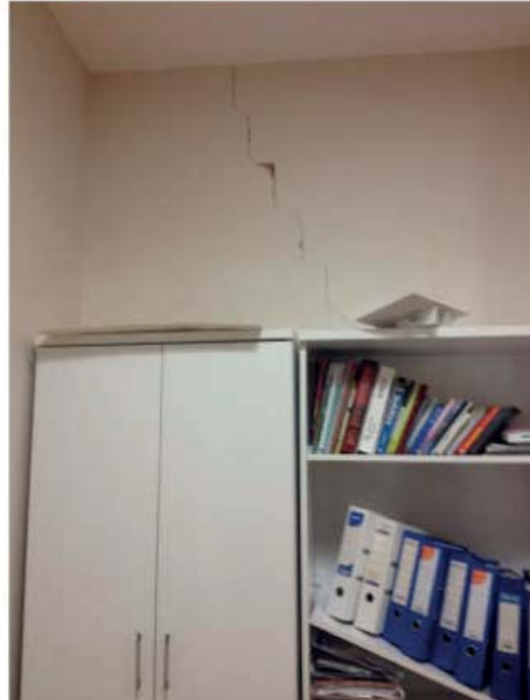
Şekil 12 - Samsat İlçe hastanesindeki yapısal olmayan hasarlar
