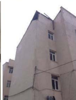
Şekil 11 - Kaymakamlık binasındaki yapısal olmayan hasarlar
