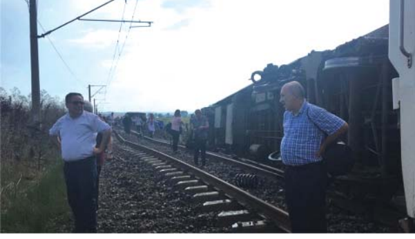
Resim 11a - Yan yatmış ikinci vagonun bulunduğu konumda rayların ve traverslerin (hat açıklığının) durumu. Yol nerdeyse bozulmamış durumda.
