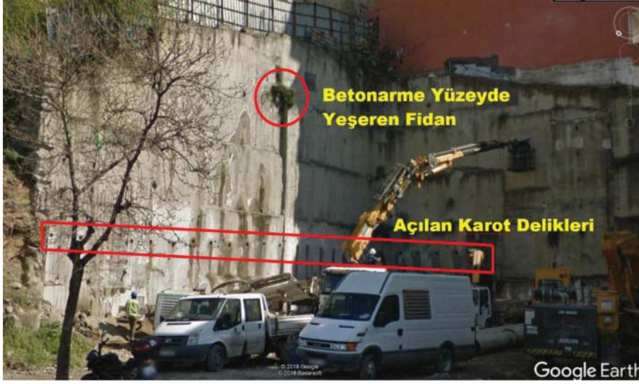
Resim 3 - 2753 ada 28 parselin mevcut betonarme dayanma yapısına sol ve arka cephede açılan karot deliklerinden ilave destek çalışmalarına başlandığını gösteren resim (Kaynak: Google Earth verileri)
