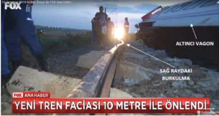
Resim 14a - Dördüncü vagonun raydan çıktığı yer. Altıncı vagonun bulunduğu konumda, trenin hareket yönüne göre sağ (güney) raydaki burkulma.
