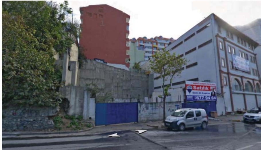
Resim 2 - 2753 ada 28 parselin Betonarme dayanma yapısının mevcut olduğu 2014 yılı fotoğrafı (Kaynak: Yandex Harita verileri)
