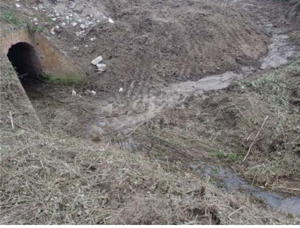
Resim 15a - Menfeze su getiren iki dereden birinin yatağı genişletilmiş ve bitkiler kısmen temizlenmiştir.
