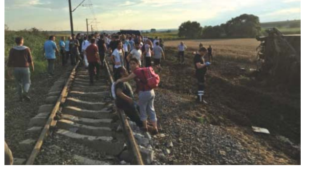
Resim 11b - Yan yatmış üçüncü vagonun bulunduğu konumda rayların ve traverslerin (hat açıklığının) durumu. Sol (kuzey) rayının altındaki traverslerin bir kısmı ötelenmiş; yol kısmen hizmet verebilir durumda.
