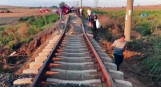
Resim 9a - Menfezi geçen altıncı vagonun tekerlekleri sol (kuzey) rayı aşmış raydan çıkarak eğik pozisyonda durmuştur (menfezin gerisinden vagonun arkadan görünümü).
