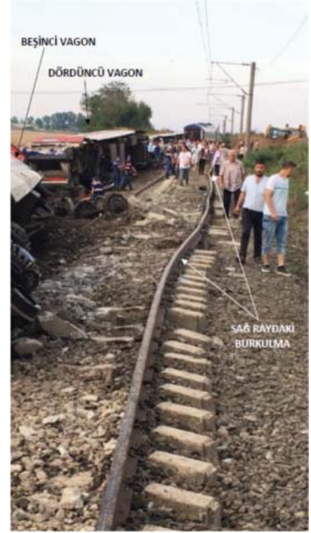
Resim 14b - İkinci vagonun raydan çıktığı yer. Dördüncü ve beşinci vagonun bulunduğu konumda, trenin hareket yönüne göre sağ (güney) raydaki burkulma. Sol rayın altındaki traversler raydan çıkmanın getirdiği zorlamayla ötelenmiş olduğundan, traversler raylara dik olması gereken pozisyonunu yitirmiştir.
