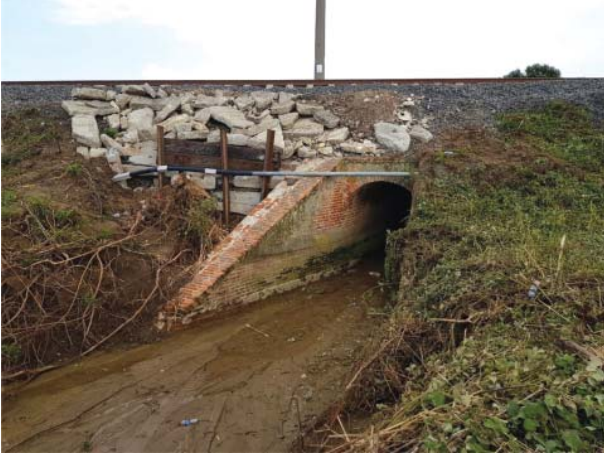
Resim 16a - Menfez dolgusunun çıkış (mansap) tarafından görünüşü. Kazık gibi çakılan çelik raylar kullanılarak dolgunun üzerine yığılan beton moloz bloklar tahkim edilmiş.
