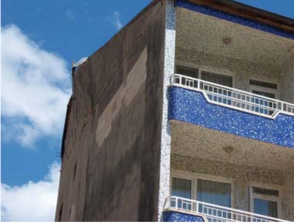
Devrilmek üzere olan ve güvenliği tehdit eden kalkan duvarı
