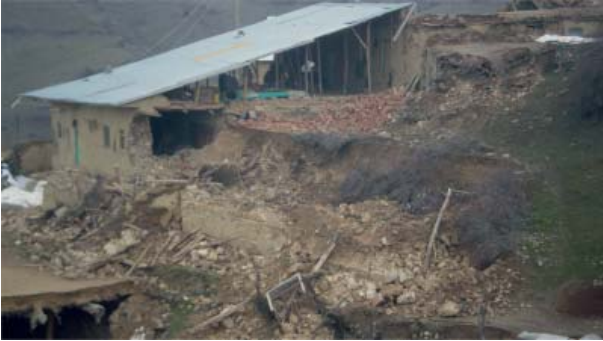
Şekil 7 - Okçular köyündeki yapı enkazları
