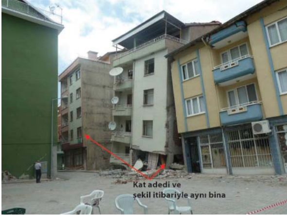
Zemin katı ve 1. Katı göçen bina
