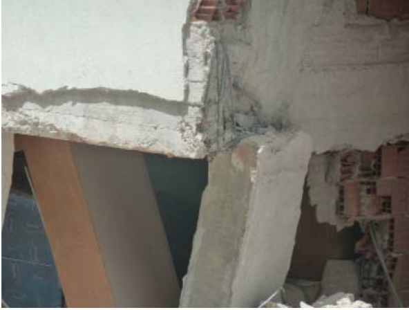
Birleşim yerinde kolonda sargı donatısı yok. Kolonlar kirişlerden daha zayıf
