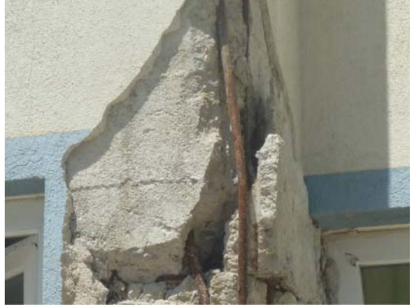
Birleşim Yerinde Kolonda sargı donatısı yok
