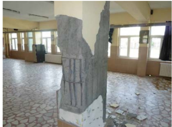
Zemin kat salondaki kolonlarda çok geniş etriye aralığı
