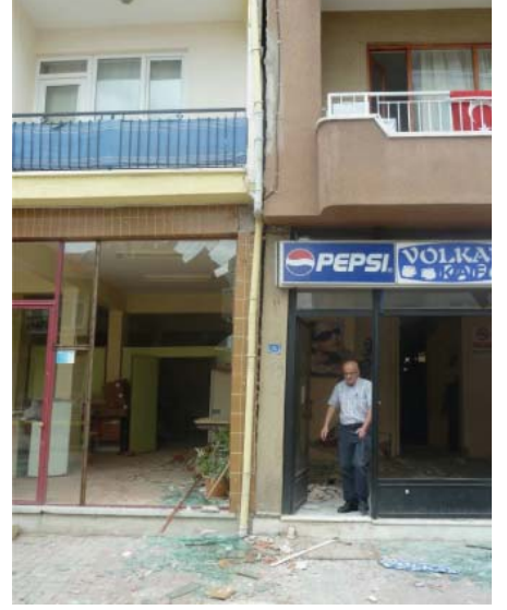
Yumuşak Kat Düzensizliği, zemin katında yaklaşık % 2.5 oranında kalıcı ötenlenme var. (Cumhuriyet Caddesi)
