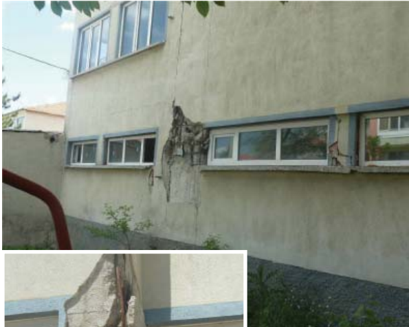
Kısa Kolon hasarları (Simav Teknik ve End. Meslek Lisesi- Önceden Boşaltılmış Ek Bina)
