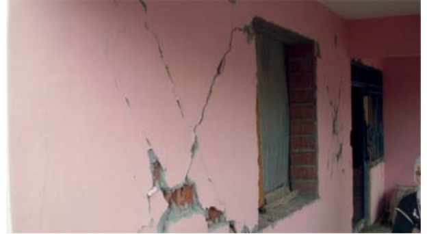
Şekil 4 - Tabanözü köyündeki tipik bir köy konutunda meydana gelen hasar örnekleri
