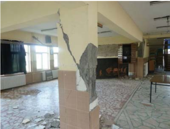
Zemin kat salondaki kolonlarda kesme kırılması
