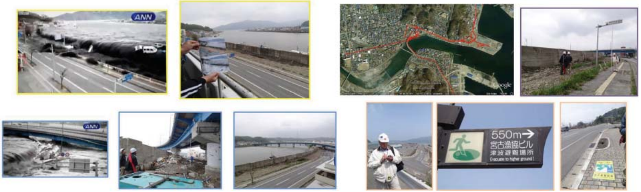
Şekil 3 - Miyako kentinde 5 m yüksekliğindeki kıyı duvarından tsunami aşması ve köprü yol düzeyine 9.4m yüksekliğe ulaşması (soldaki resimler), tsunami durumunda kaçma yolları ile ilgili önceden hazırlanmış faydalı işaretler (sağdaki resimler)
