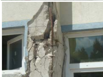
Kısa Kolon hasarları (Simav Teknik ve End. Meslek Lisesi- Önceden Boşaltılmış Ek Bina)
