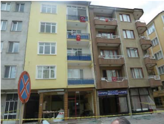
Çarpma izleri olan iki komşu bina. (Cumhuriyet Cad. No:1deki köşe bina)
