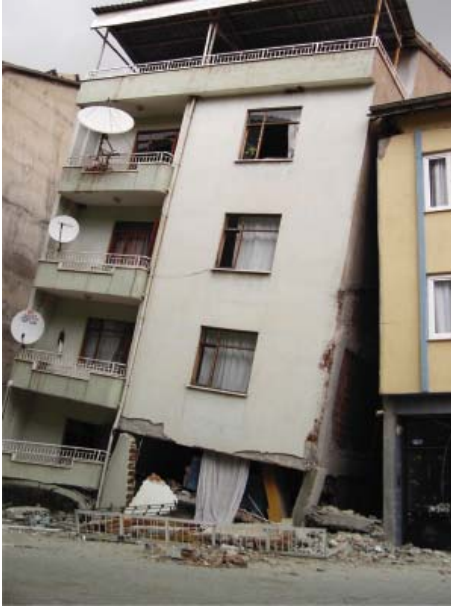
Şekil 2 - Zemin katı tamamen yıkılmış binadan bir görünüm
