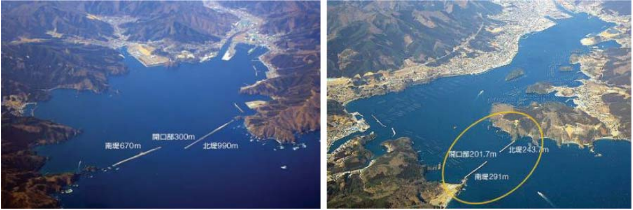
Şekil 5 - Kamaishi (solda) ve Ofunato (sağda) kentlerindeki tsunami dalgakıranları
