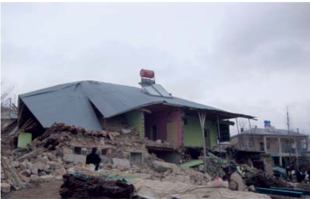
Şekil 9 - Okçular köyündeki tamamen yıkık durumda olan yığma bir bina ile hemen yanında hasarsız bir betonarme yapı
