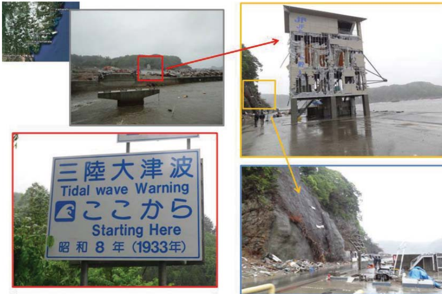
Şekil 2 - Taro kentinde 2011 tsunamisinin su düzeyi nedeni ile yapıda verdiği hasar (sağ üst), 1933 tsunamisi baskın alanı sınır (sol alt), 1896 ve 1933 tsunamileri nedeniyle oluşan en yüksek su düzeylerinin işaretleri (sağ alt)
