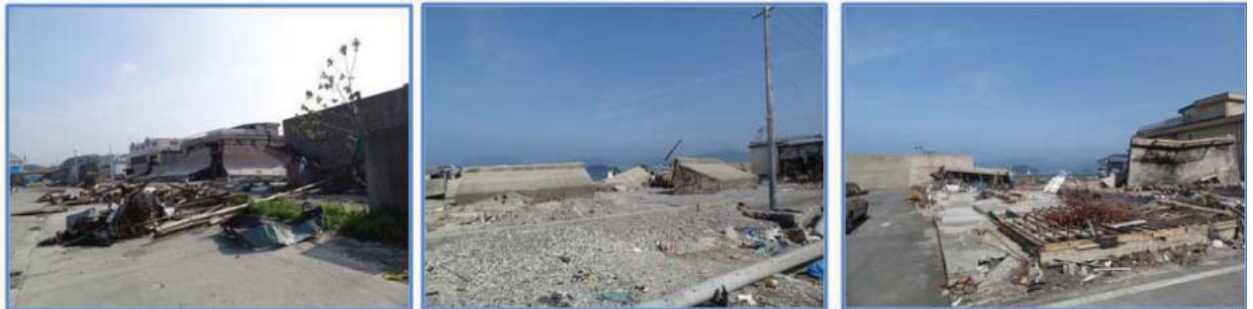
Şekil 4 - Yamada kentinde yıkılan 5m yüksekliğindeki beton kıyı duvarları
