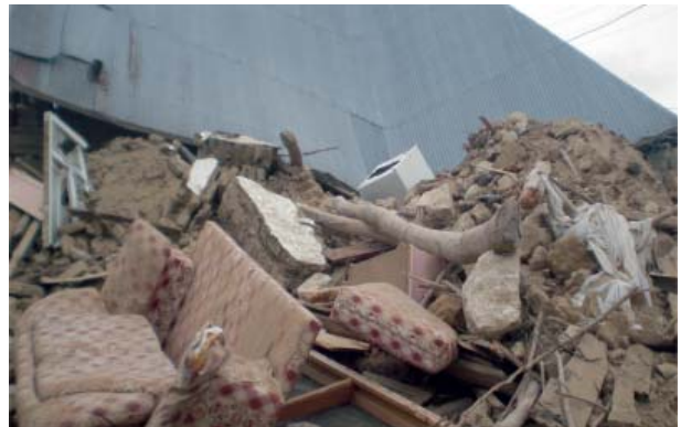
Şekil 10 - Okçular köyündeki tamamen yıkık durumda olan yığma yapı
