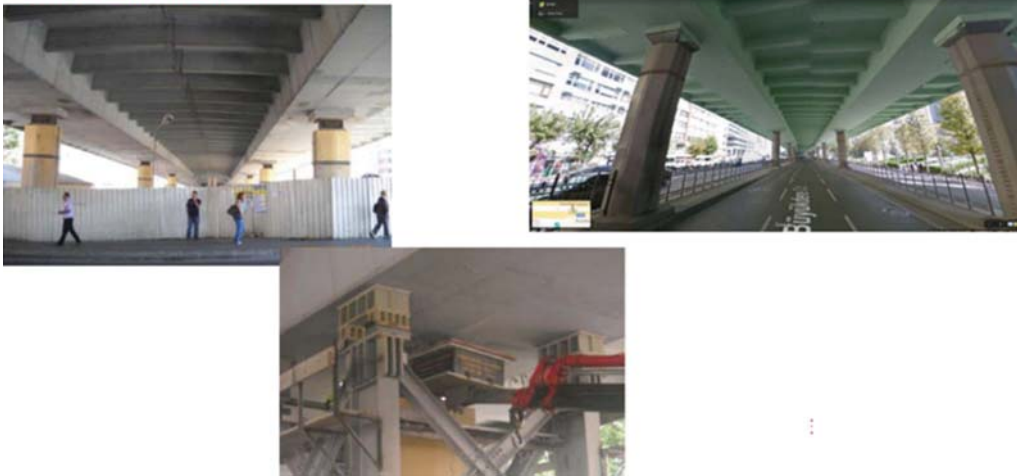
Şekil 10 - Mecidiyeköy viyadüğü deprem yalıtımlı güçlendirmesi ( EMKE İnş.)
