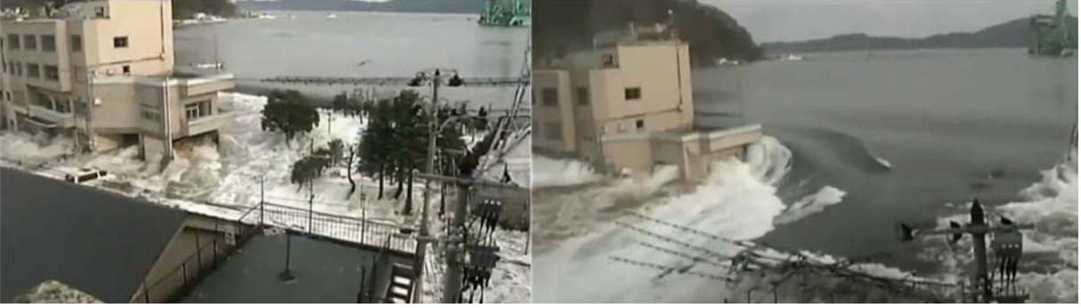
Şekil 5 - Japonya Kamaishi şehrinde betonarme ve ahşap yapılara ve ağaçlara tsunami etkisi. Betonarme yapı yıkılmazken, ahşap yapı ve ağaçlar sürüklenmiştir.
