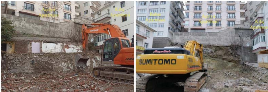
Şekil 6 - 8139 ada 12 parselde yapılan kazıdan görüntüler (a) 8139/12 parseldeki eski binanın yıkımından ve henüz 8139/20 istinat duvarının alt kısmı kazılmamışken bir görüntü, (b) enkaz kaldırıldıktan ve istinat duvarının altında kazı yapıldıktan sonra yeşil-kahve renkli ayrıışmış grovak birimlerin görünümü
