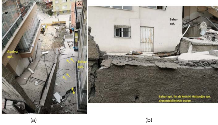
Şekil 21 - (a) Altay Sokaktan, Açelya Apartmanı (8139/20) ile Bahar Apartmanı (8139/19) arasından aşağı bakış (10 Nisan 2021), (b) 17 Nisan 2021’de Hatipoğlu Apartmanı (8139/13) içinden Bahar Apartmanı (8139/19) temel seviyesine doğru bakış (bu istinat duvarının alt kısmındaki yığma taş kısım aşırı hasar görmüş ve dökülmüştür, Şekil 16)
