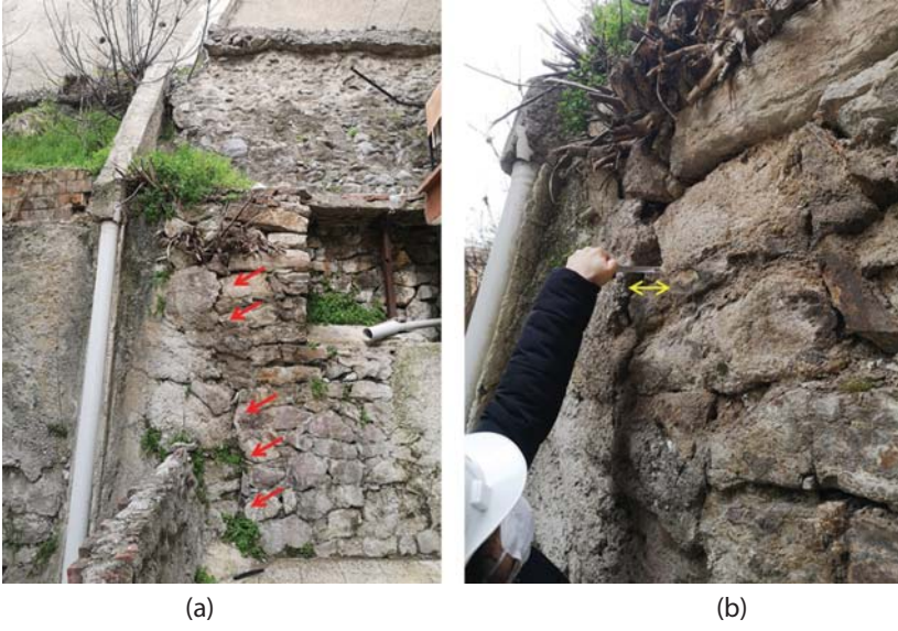
Şekil 14 - Hatipoğlu Apartmanı (8139/13) arkasındaki istinat yapısı (fotoğraf Şekil 13 (a)'daki A lokasyonundan çekilmiştir)
