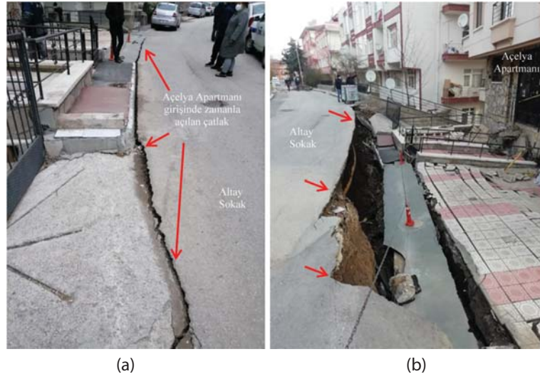
Şekil 7 - (a) Altay sokakta 8139 ada 20 parseldeki binanın girişinde oluşan çatlağın zaman içinde gelişimi ve (b) aynı çatlağın ilerlemesi sonucu yaklaşık 1.5 m yatay ve düşey hareket
