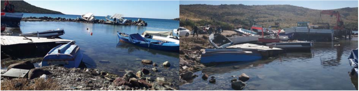
Şekil 1 - Zeytineli balıkçı barınağı ve teknelerde 30 Ekim tsunamisi sebebiyle oluşan hasar
