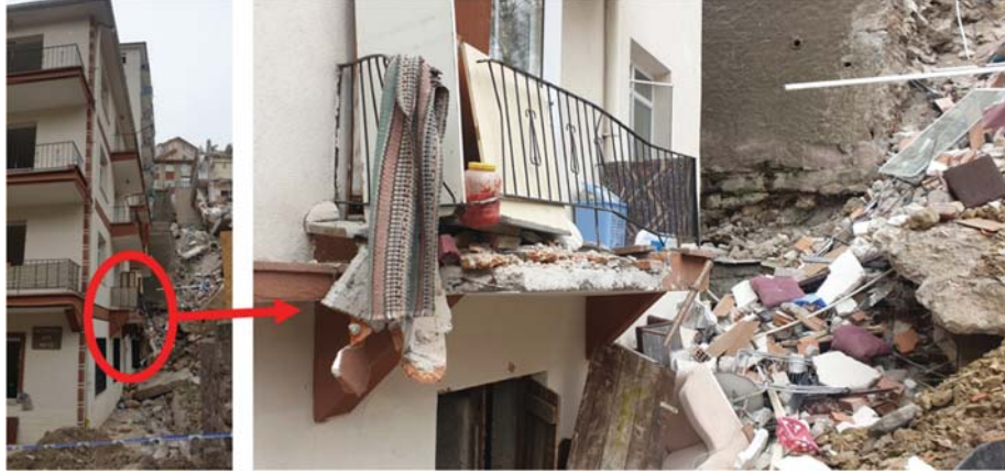
Şekil 17 - Hatipoğlu Apartmanı'nda yıkım kaynaklı oluşan yapısal olmayan hasarlar
