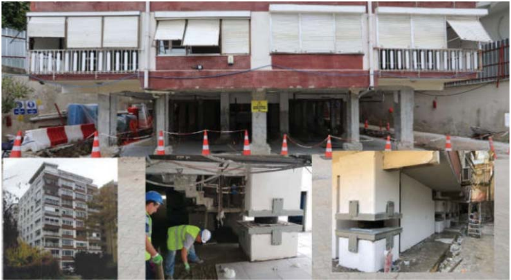
Şekil 13 - Deprem yalıtımlı olarak güçlendirilen konut binası (FREYSAŞ)
