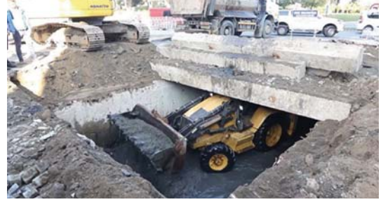
Şekil 23 - Akarsuyun Şehir Geçişi üstü kapatılan akarsu içerisinde çökelen çamurun iş makinası ile temizlenmesi
