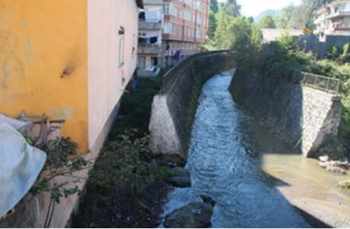
Şekil 16 - Yerleşim sahası içinde trapez en kesitli yapı. Kıyı Kenar Çizgisi/Trapez En Kesit
