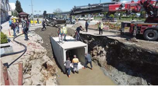
Şekil 22 - Akarsuyun Şehir Geçişi Kutu Menfez Yerleştirilmesi
