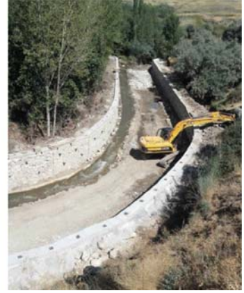
Şekil 11 - Memba kısımda taşkın koruma yapısı (Van) Yatayda Kurbaşı olan bir akarsu ıslahında taban ve duvarlar (Dikdörtgen en kesit)
