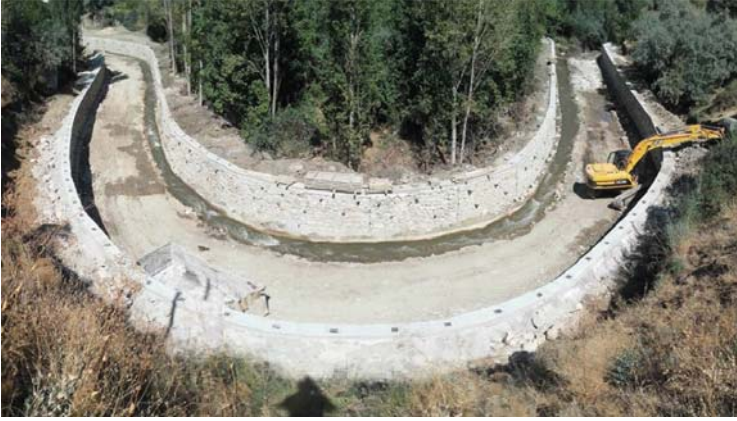
Şekil 11 - Memba kısımda taşkın koruma yapısı (Van) Yatayda Kurbaşı olan bir akarsu ıslahında taban ve duvarlar (Dikdörtgen en kesit)
