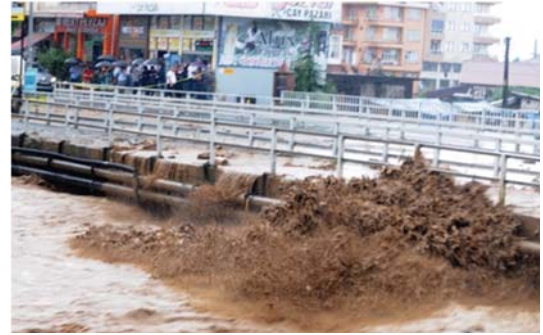
Şekil 25 - Köprü Yüksekliği ve Taşkın debisinin Geçmemesi
