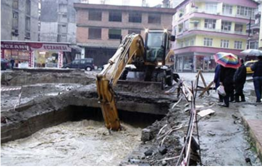
Şekil 24 - Akarsuyun Şehir Geçişi üstü kapatılan akarsu içerisinde çökelen çamurun iş makinası ile temizlenmesi
