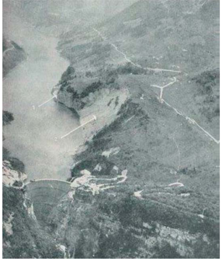
Foto 2 - Vajont Barajı göl alanında oluşan heyelanların görünüşü, (Şekercioğlu, E.)
