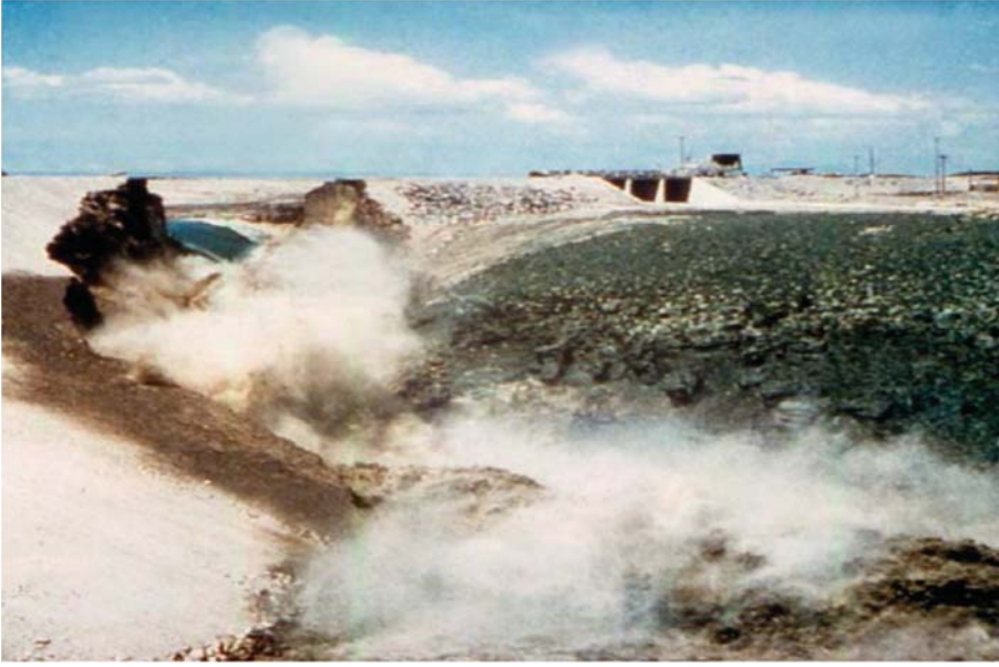
Foto 1 - Teton barajının yıkılışı sırasında çekilen bir görüntü (Şekercioğlu, E.)
