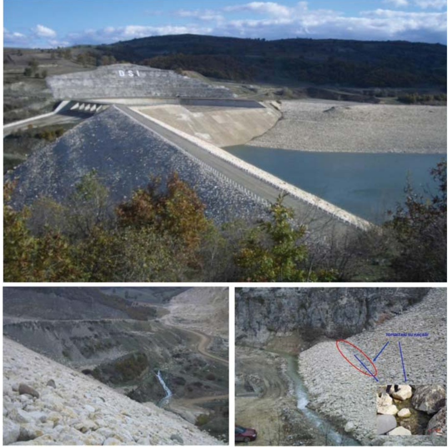
Foto 5 - Vezirköprü Barajı genel görünüşü ve mansabında oluşan su kaçaklarının görünüşü, (Çalışkan M. ve arkadaşları.)
