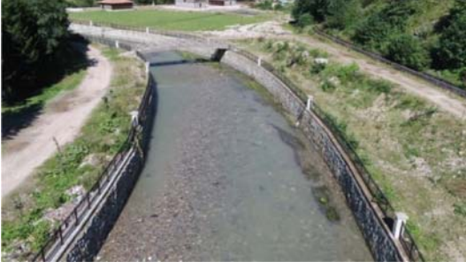
Şekil 13 - U-En kesitte Taşkın Koruma Yapısı
