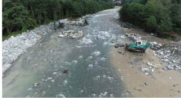
Şekil 17 - Doğal en kesitte yatak malzemesinden tahkimat inşası
