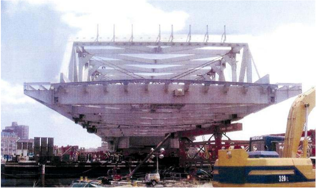
Şekil 4. Yeni köprünün okyanus mavnası üzerinde döndürülerek montaj mavnaları üzerine alınması
