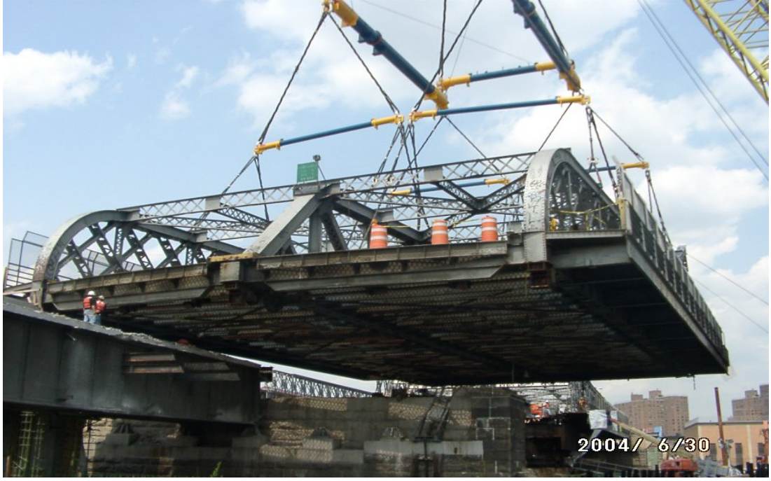
Şekil 5. Eski köprünün sökülmesi
