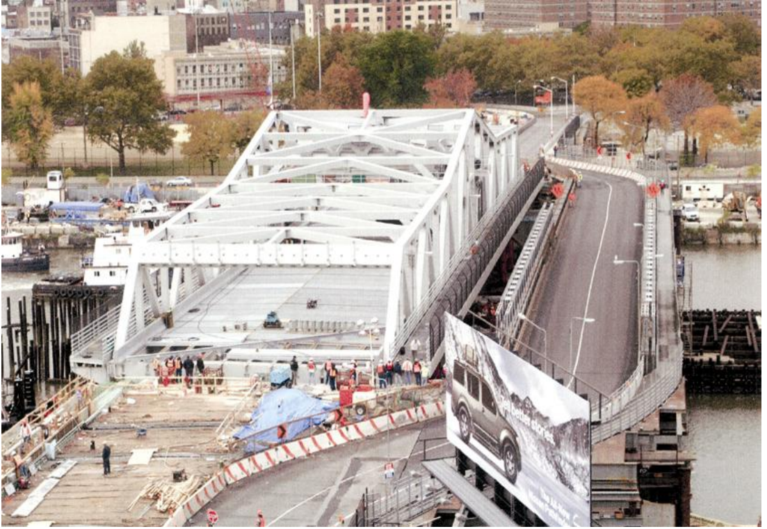
Şekil 7. Yeni köprünün yerine yerleştirilmiş hali
