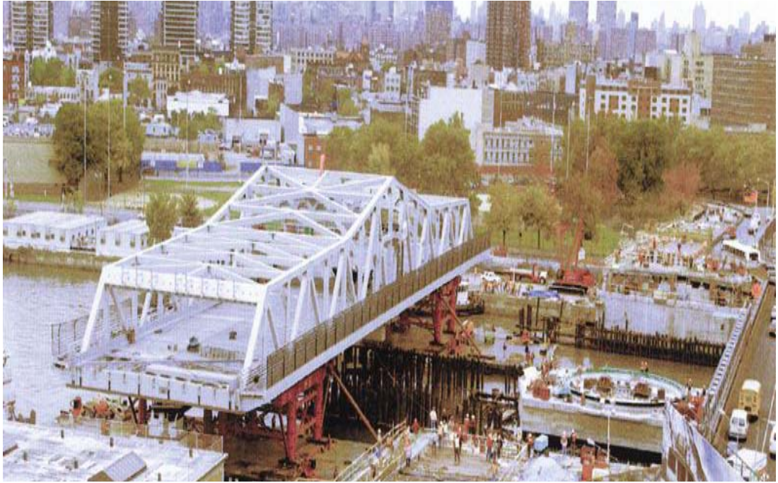
Şekil 6. Yeni köprünün yerine yüzdürülmesi
