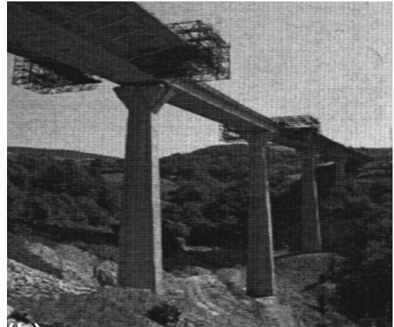
Şekil 6. River Sella viyadüğünün yapım yöntemi
