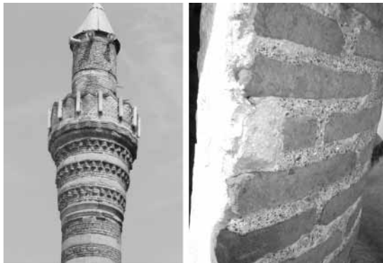
Şekil 7 Tarihi minarenin dış ve iç kısımlarında zamana bağlı gerçekleşen bozulmalar.
