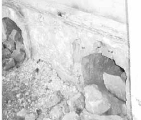
Şekil 6. Binanın Cephe Penceresi
