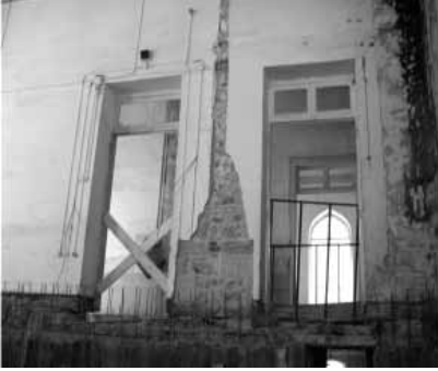
Şekil 13. Sıvaların Sökülmesi
