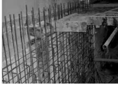
Şekil 8. Bodrum Kat Duvarlarının Güçlendirilmesi
