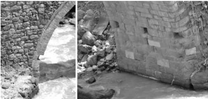
Şekil 9 Tarihi köprünün kemer bölgesinde zamana bağlı gerçekleşen bozulmalar.
