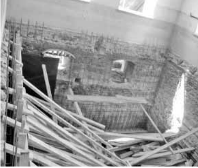
Şekil 9. Bodrum Kat Duvarlarının Güçlendirilmesi
