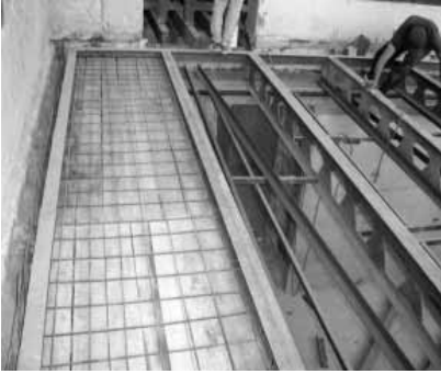
Şekil 23. Döşemeye Donatı Yerleştirme
