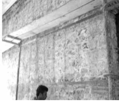
Şekil 14. Sıvaların Sökülmesi
