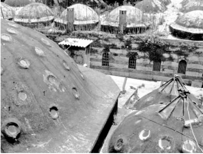
Şekil 6. Harç ve bitüm kaplı kubbeler
