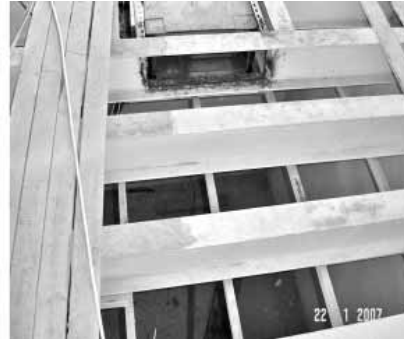
Şekil 20.Hasarlı Döşemelerin Çelik Profillerle Değiştirilmesi
