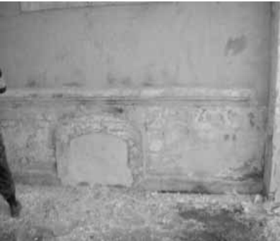
Şekil 17. Cephe Sövelerinin ve Bodrum Kat Penceresinin Açılmadan Önceki Hali
