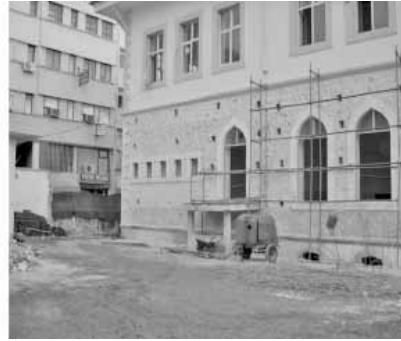
Şekil 12. Cephe Sıvalarının Sökülmesi
