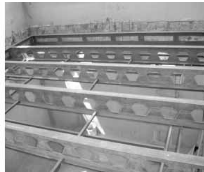
Şekil 22.Hasarlı Döşemelerin Çelik Profillerle Değiştirilmesi
