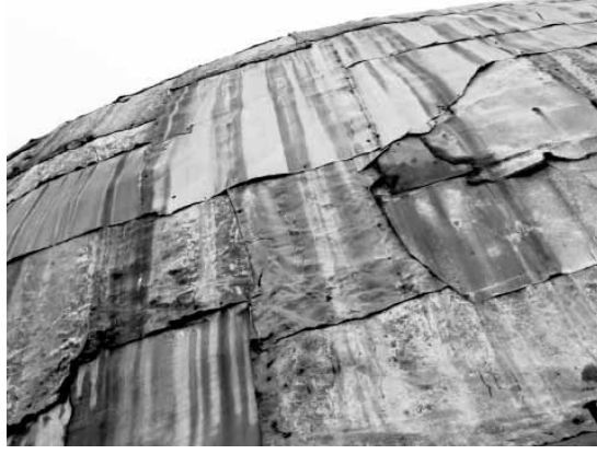
Şekil 5 Kurşun kaplama.
