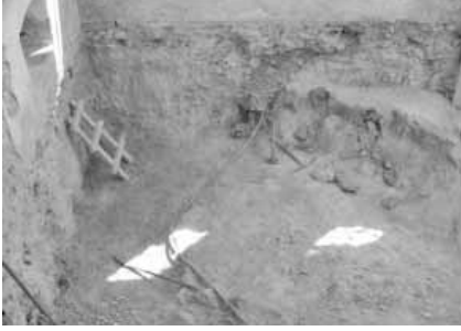
Şekil 7. Binanın Bodrum Katının Kazılarak Yükseltilmesi
