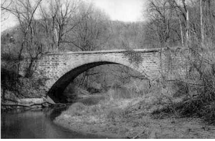
Şekil 1. Tek açıklıklı simetrik parabolik guseli bir tarihi köprü
