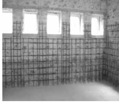
Şekil 24. Üst Kat Duvarlarının Güçlendirilmesi
