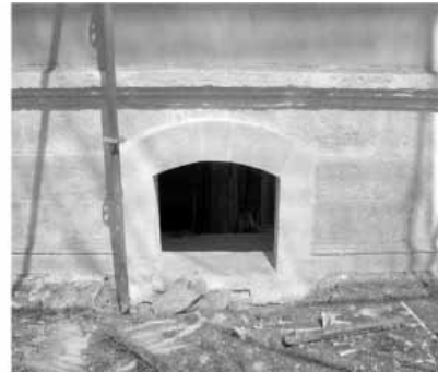
Şekil 18. Cephe Sövelerinin ve Bodrum Kat Penceresinin Açıldıktan Sonraki Hali
