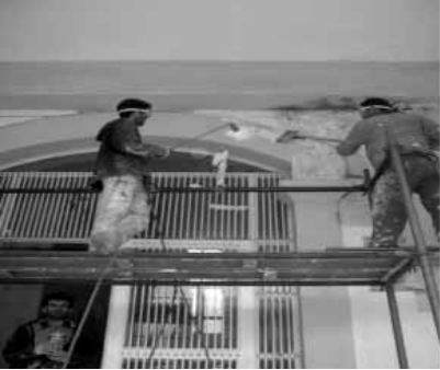
Şekil 15. Sövelerin Temizlenmesi
