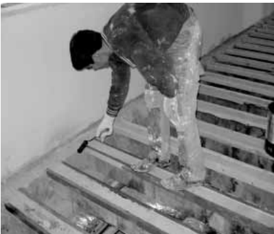
Şekil 21.Ahşap Döşemelerin Temizlenmesi
