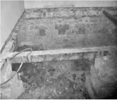
Şekil 19.Hasarlı Döşemelerin Kaldırılması
