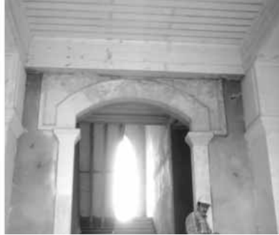
Şekil 16. Sıvaların Sökülerek Sövelerin Ortaya Çıkartılması
