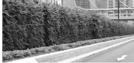
Şekil 2 Bitkilendirme ile uygulanmış karayolu perdeleri ( [www.roadtraffic-technology.com](http://www.roadtraffic-technology.com) /Şubat 2015, [www.greening.gov.hk](http://www.greening.gov.hk) /Şubat 2015).
