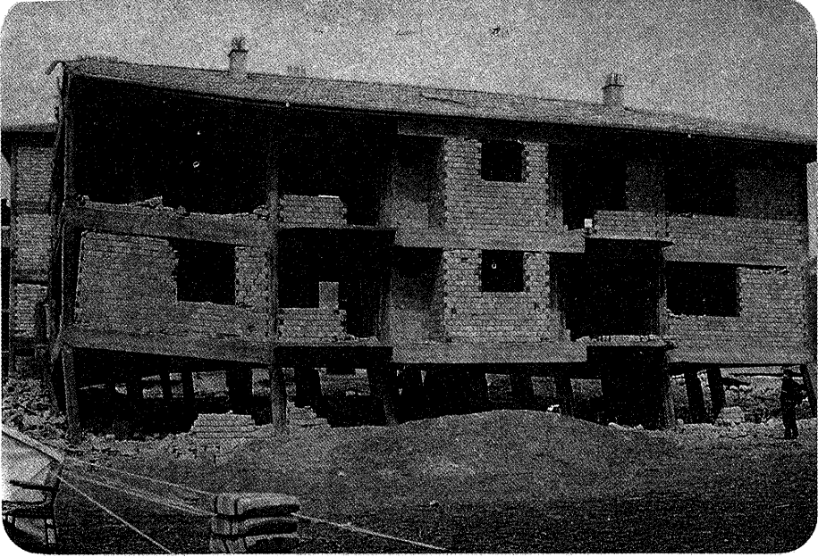
Şekil 5- Yumuşak Kat Ötelenmesi
