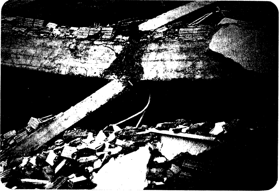
Şekil 2- Kuvvetli Kiriş-Zayıf Kolon
