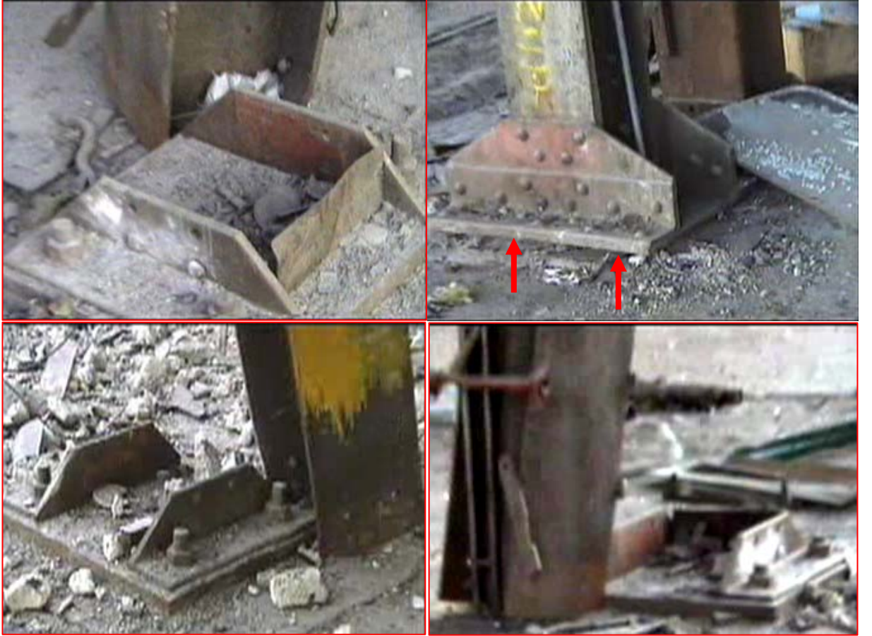
Şekil 10. Kolon mesnet hasarları
