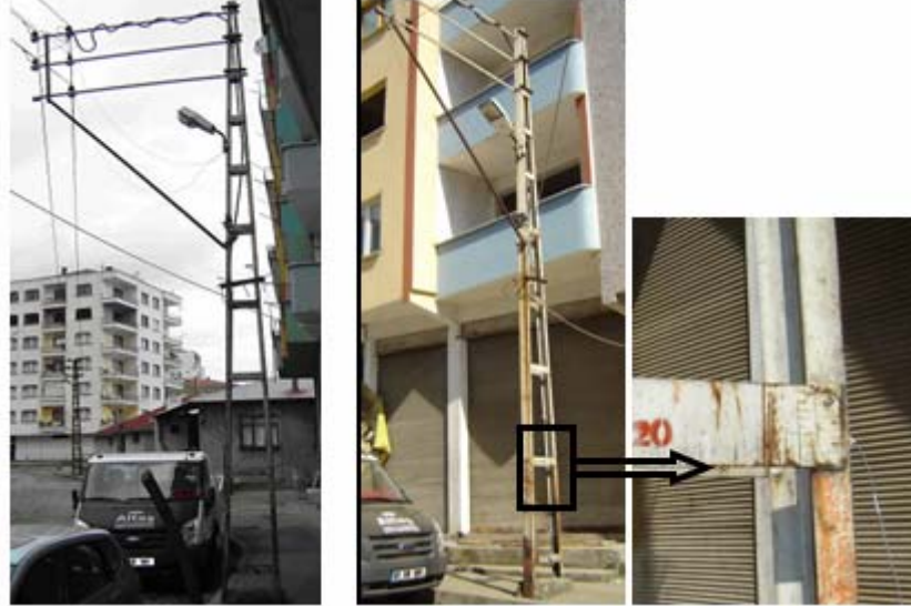
Şekil 2. Elektrik direğine ait görüntüler.
