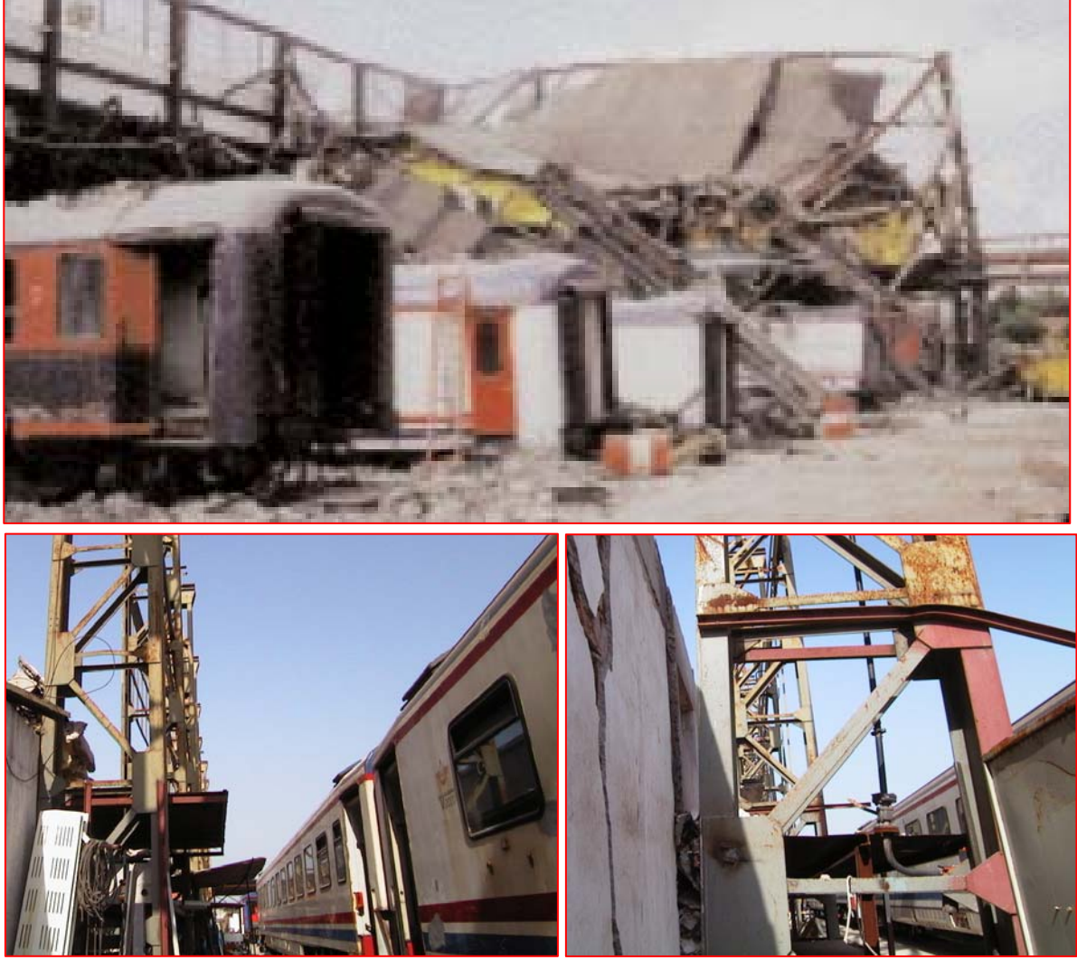
Şekil 9. Fabrika hasarından görünüş
