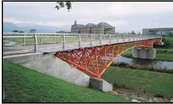
Şekil 3. Hareketli yüklere maruz uzay kafes sistem köprü örneği [1]
