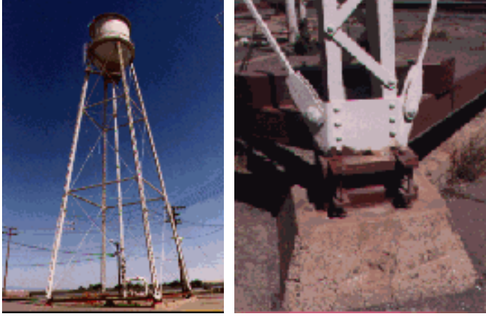
Şekil 1. Sürtünmeli sarkaç mesnetlerinin üzerine oturan amonyak tankı [26]
