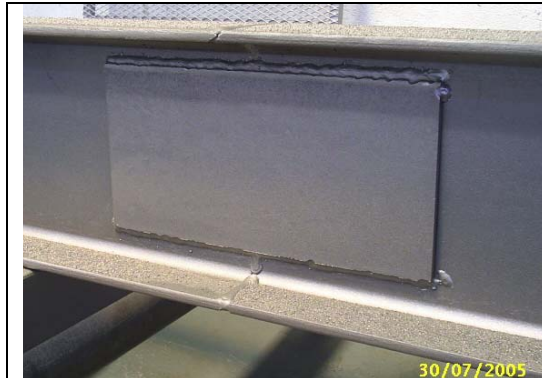
Resim 8: Kumlama işlemi kaynaklamadan sonra yapılır, [9]
