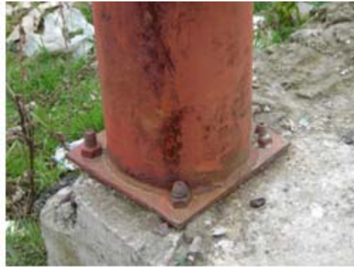
Şekil 8. Çelik kolon-temel birleşimi.
