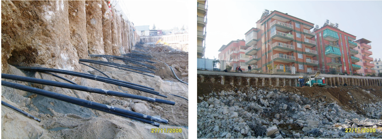
Şekil 1. Uygulamanın yapıldığı fore kazık ve ankraklı iksa sisteminin yapımı.
