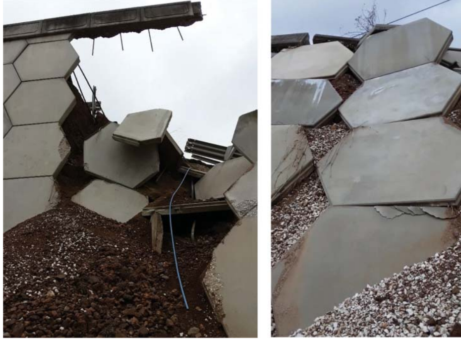
Şekil 7 - Duvar cephe elemanı olarak kullanılan prekast betonarme altıgen paneller
