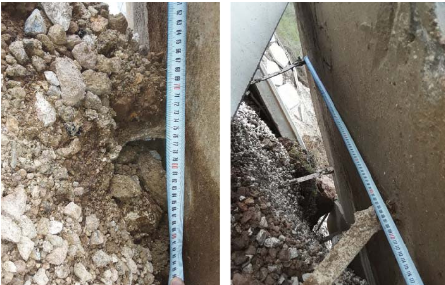
Şekil 6 - Zemin donatı şeritleri yatay ve düşey aralıkları
