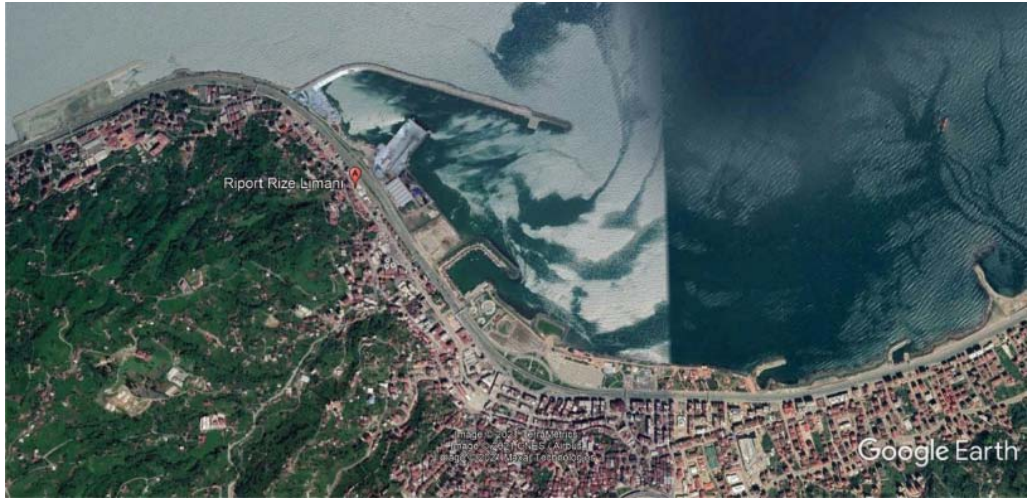
Şekil 3 - Riport Rize Limanı görünüşü
