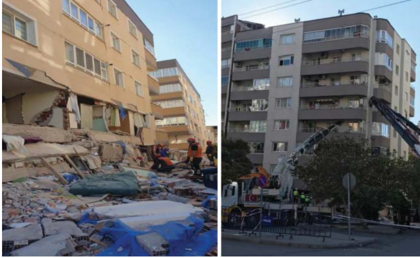
Şekil 4 - Alt katlarda göçme görülen bazı binalar
