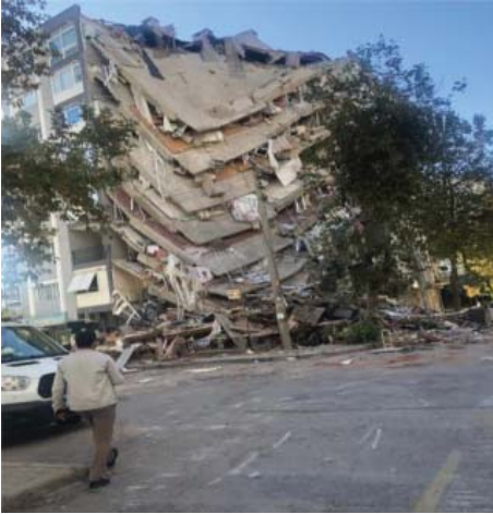
Şekil 5 - Planda kısmi göçme görülen bir yapı
