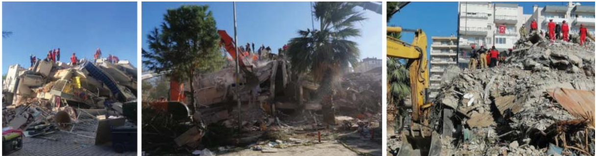
Şekil 3 - Sandviç tipi göçen yapılardan bazıları
