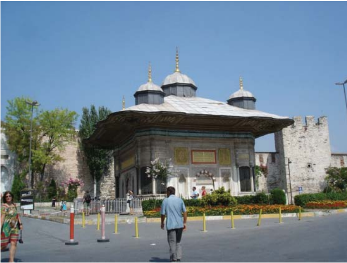
Şekil 10 - Topkapı Sarayı önünde taşıt yollarıyla kuşatılmış ve çalışmayan III. Ahmet Çeşmesi, İstanbul
