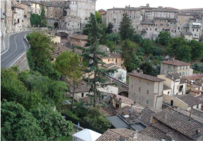
Şekil 8 - Topografya içindeki kentsel kotlardan biri olan su kemeri
