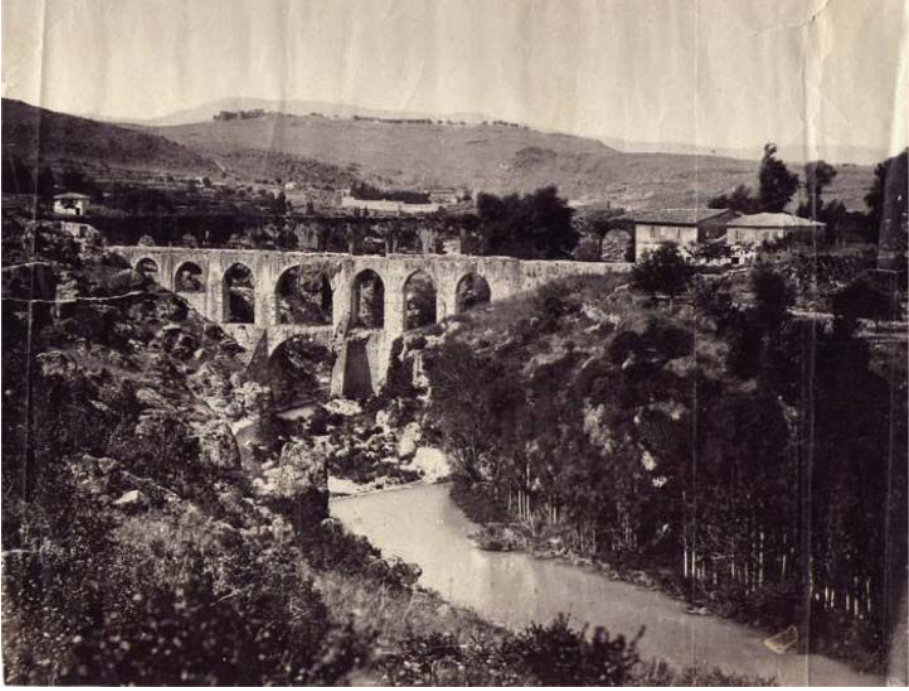
Şekil 7 - Kızılçullu aquaduct'ünün 20. yy'ın başındaki hali.
