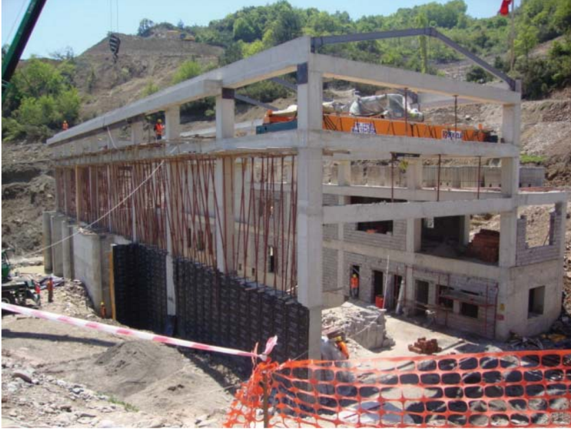
Şekil 2.9 - Örnek Santral Binası İnşaatı
