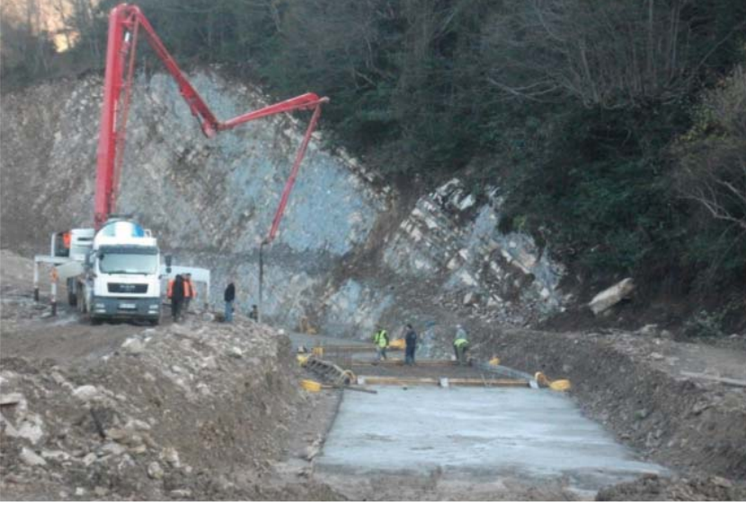
Şekil 2.3 - Kanal İnşaatından Görüntü
