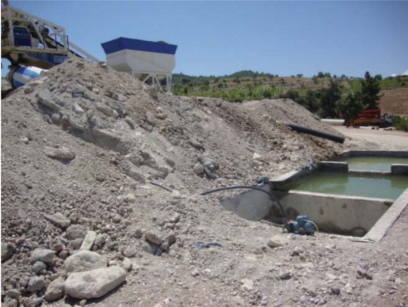
Şekil 2.6 - Örnek Beton Santrali Yıkama Suyu Çökeltim Havuzu
