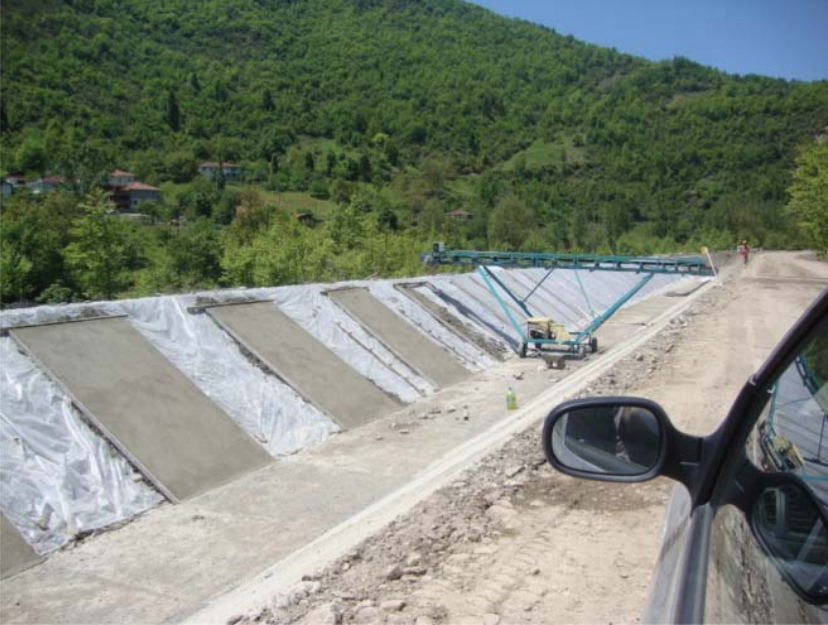
Şekil 2.8 - Örnek Trapez Kanal İnşaatı
