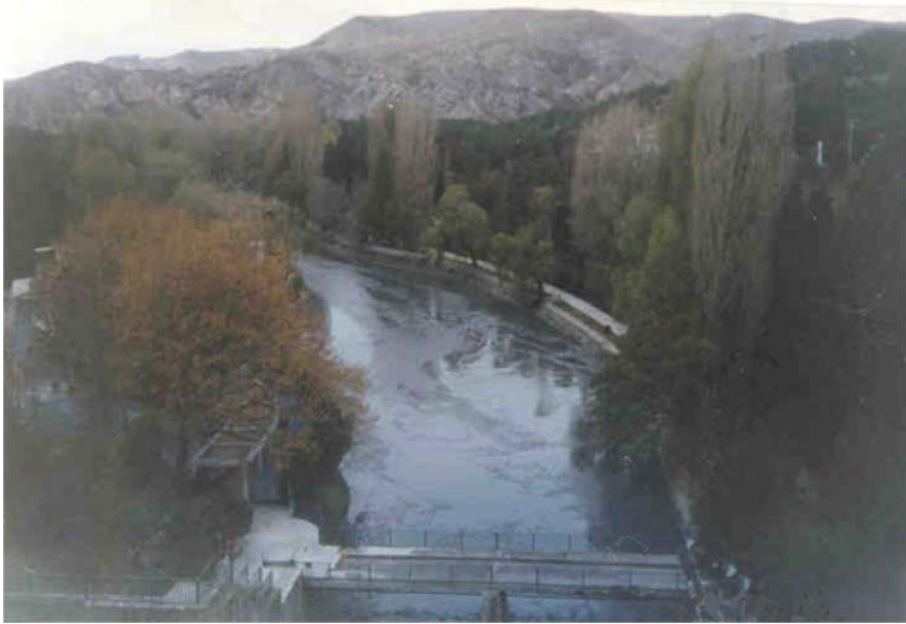
Şekil 6 - Çubuk I Barajındaki Yıkamadan Sonra Mansap Kanalına Çökelen Malzemenin Görünüşü
