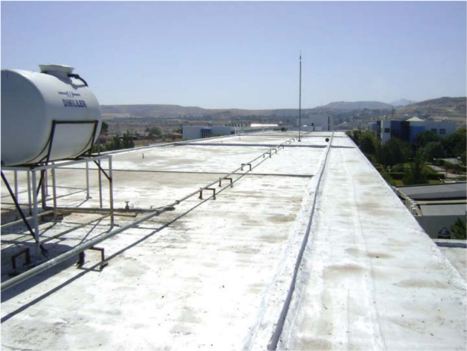
Foto 2 - Drenaj alanı olarak kullanılan çatı görünüşü
