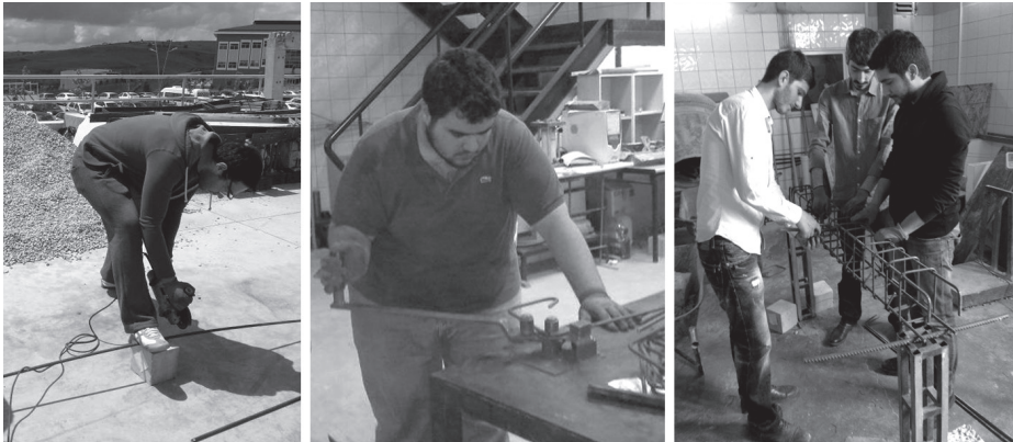
Şekil 3 – Donatı kafesinin hazırlanışı
