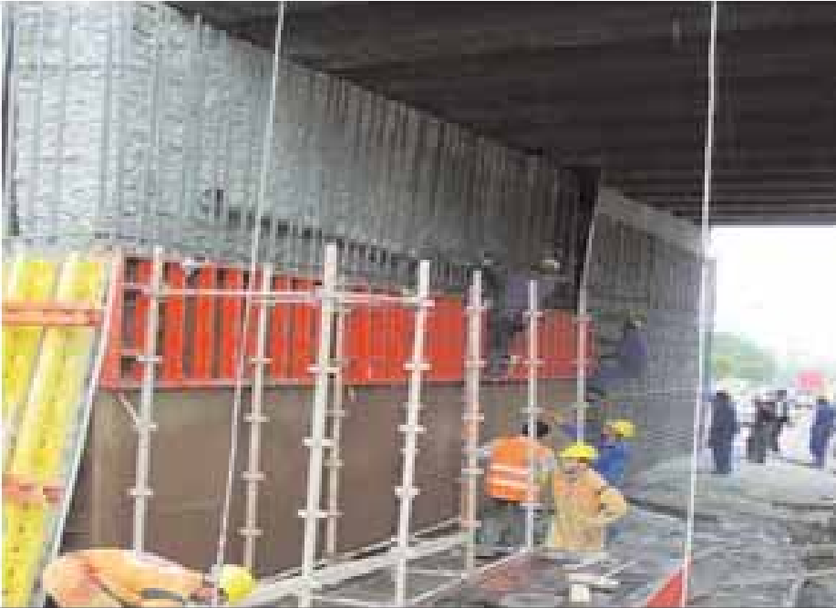
Şekil 4: Sağmalcılar Viyadüğü ve Osmaniye Köprüsü deprem güçlendirme çalışmaları
