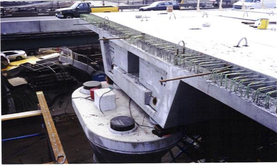
Şekil 1. Daire elastomer mesnet kullanımı (1).
