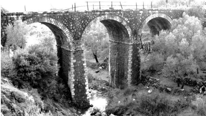
Şekil 1. Üç açıklıklı kemer köprü İzmir - Çeşme – Zeytinler
