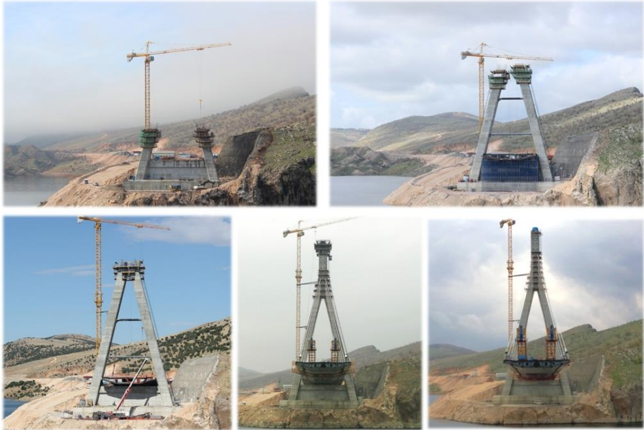
Şekil 11. Pilon Yapım Aşamaları.
