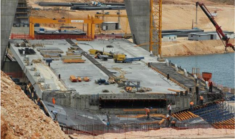
Şekil 6. İkinci Aşaması tamamlanmış betonarme tabliye.
