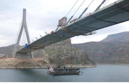
Şekil 15. Kahta tarafı 200metre uzunluğunda konsol.
