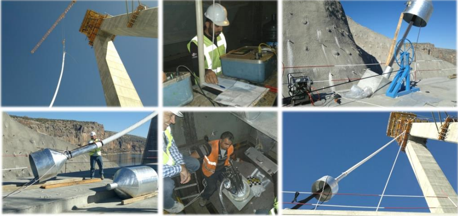
Şekil 8. Monte edilen askı sisteminin detayları.
