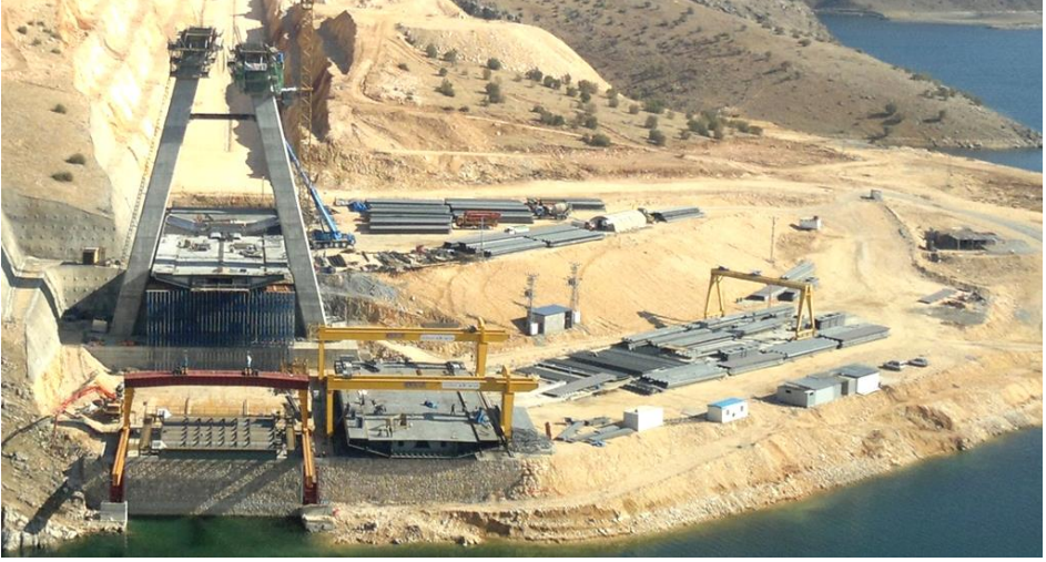
Şekil 13. Köprünün çelik segmentlerinin montaj alanı (Diyarbakır tarafı).
