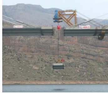
Şekil 15. Kahta tarafı 200metre uzunluğunda konsol.
