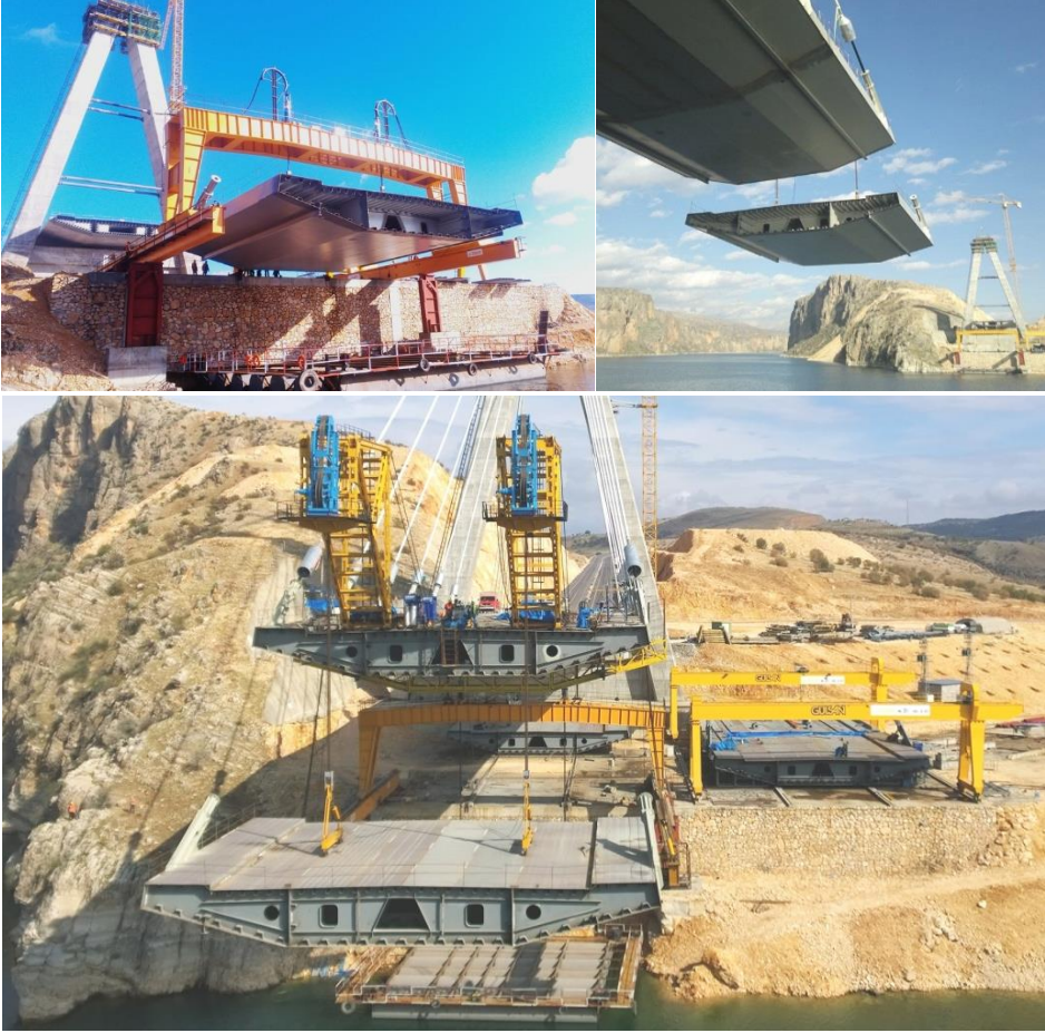
Şekil 14. Çelik segmentin dubaya indirilmesi ve Çelik Segmentinin Kaldırma.
