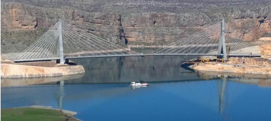
Şekil 17. Nissibi köprüsü (Şubat 2015).
