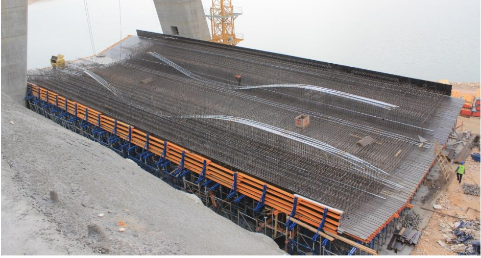
Şekil 5. Birinci Aşama betonarme yabliye.
