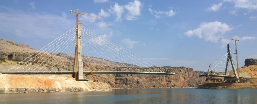
Şekil 15. Kahta tarafı 200metre uzunluğunda konsol.
