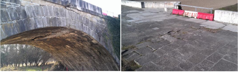
Şekil 11. İkinci kemer alt yüzü ve üst yüzünde belirlenen bozulmalar
