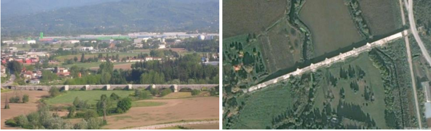
Şekil 1. Köprünün kuzeyden ve uydudan görünüşü
