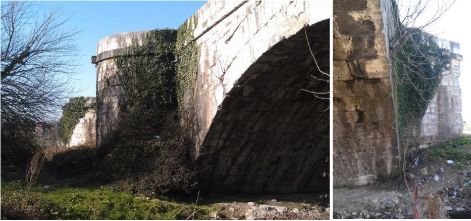
Şekil 13. Güney ve kuzey cephelere yerleşen bitki kolonileri ve ağaç kökleri
