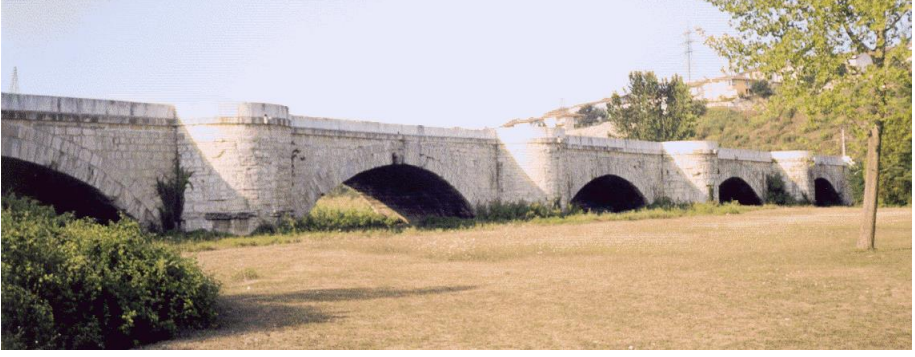
Şekil 2. Köprü gövdesi ve kuru nehir yatağı (Güney cephe)
