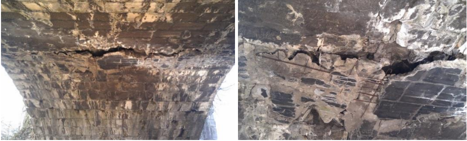
Şekil 12. İkinci kemer alt yüzünde yapılan onarım ve bozulmalar
