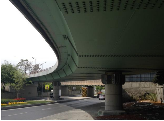
Fotoğraf 1. Köprü genel görünüşü
