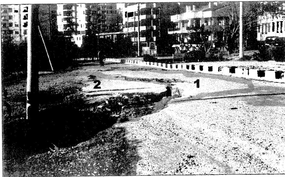
Şekil 5. Tufa falezlerinde çoklu blok kayması sonucu Eski Lara Yolu'ndaki kırıklar.
