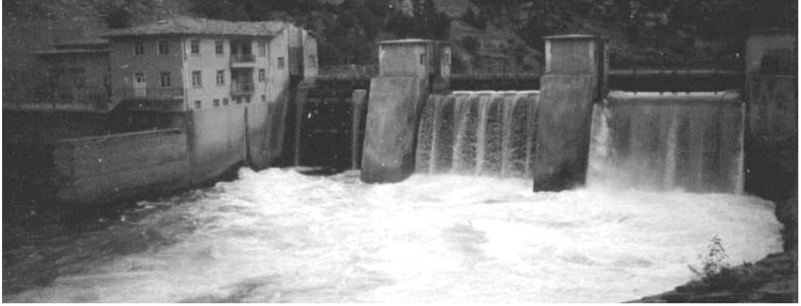
Şekil 6 – Ceyhan üstünde, 3,6 MW gücünde, alçak düşülü Maraş nehir içi santrali (Foto: Ü.Öziş).
