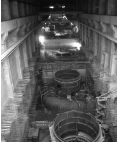
Şekil 2 – Atatürk barajı etek santralinde türbin ve jeneratör montajları (Foto: Ü.Öziş).
