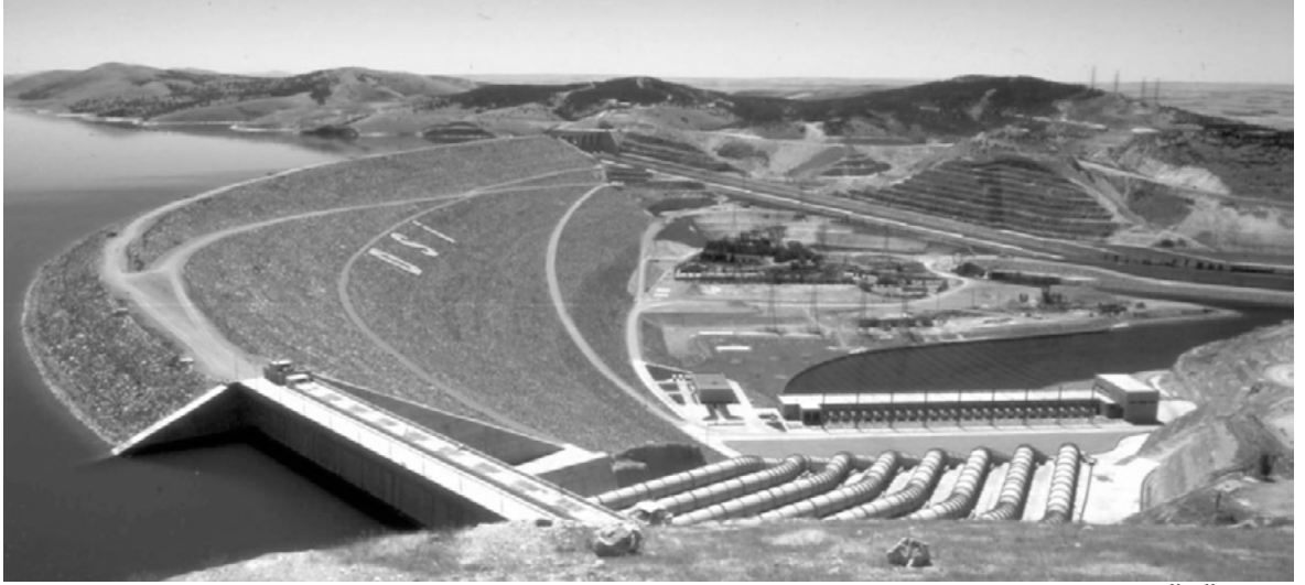
Şekil 1 – Fırat üstünde Atatürk barajı ve 2400 MW gücünde etek santrali (Foto:Ü.Öziş).
