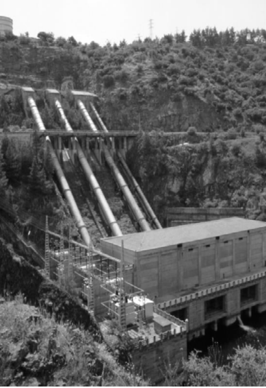
Şekil 9 – Gediz havzasında, Demirköprü barajıyla derlenen suyu 2,4 km uzunluğunda basınçlı bir tünelle çevrilen, 107 m düşülü çevirme santrali (Foto: Ü.Öziş).
