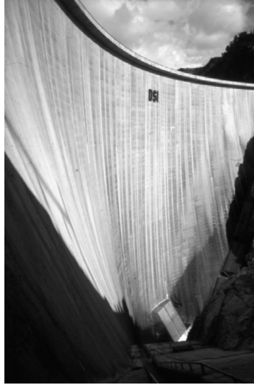
Şekil 5 – Manavgat üstünde, temelden 185 m yüksekliğinde Oymapınar kemer barajı (Foto: Ü.Öziş).
