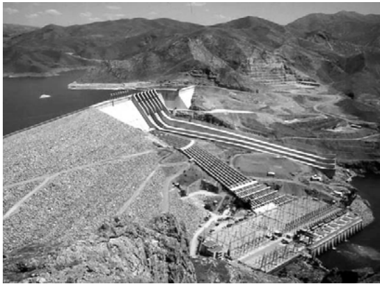
Şekil 7 – Fırat üstünde, Keban Barajı ve 1330 MW gücünde etek santrali (Foto: Ü.Öziş).
