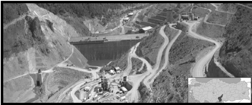
Şekil 8 Köprü Barajı Yapım Aşaması. ('Google' görselleri, 2014-2015)
