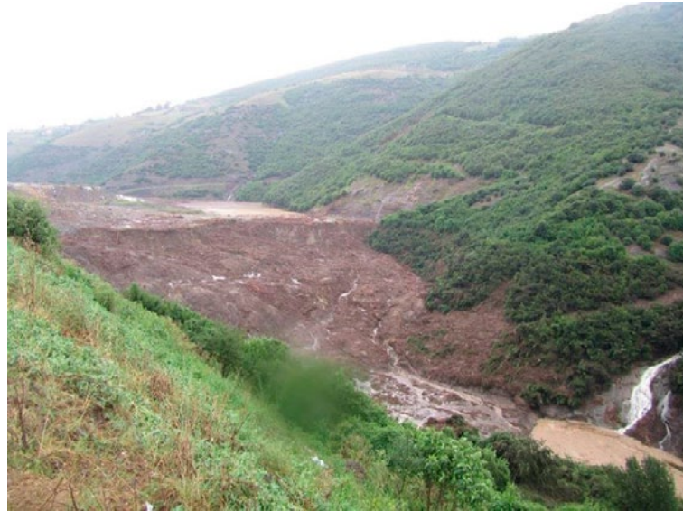
Şekil-9 Taşkın sonrası Yılanlıdere Sel Kapanı.
