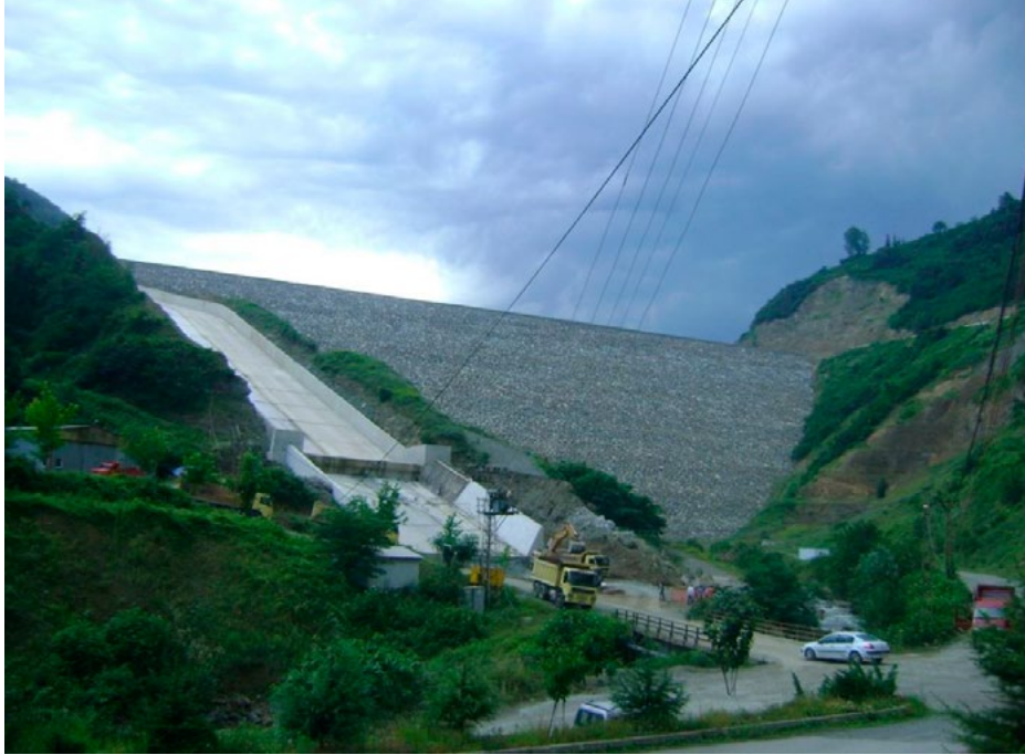
Şekil-7 Atasu Barajı 2010.
