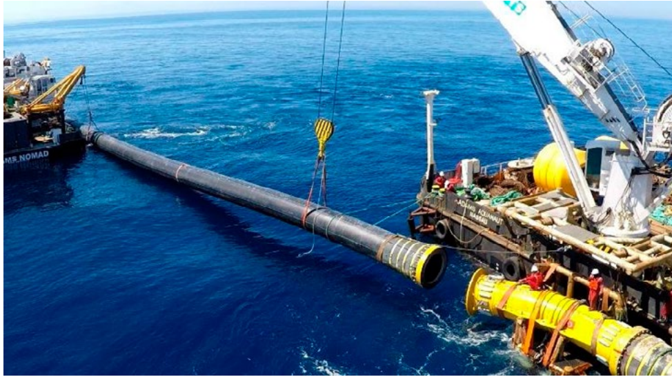
Şekil-5 HDPE boruların denize indirilme çalışmalarından bir görüntü.
