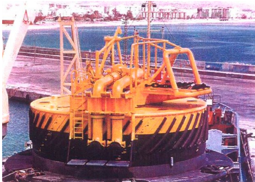
Şekil-3 Tankerlere dolum yapacak yükleme tesisi (SPM ünitesi).
