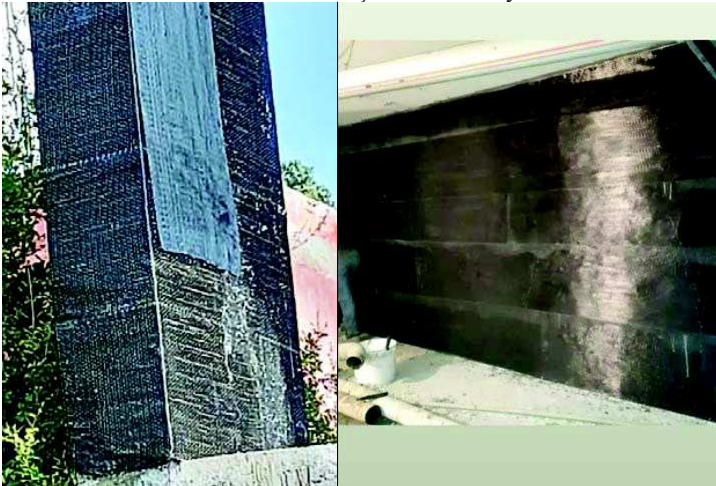
Şekil 3. a) Köşe Pahı yapılmamış CFRP, b) Reçinesi yedirilmemiş CFRP uygulaması
