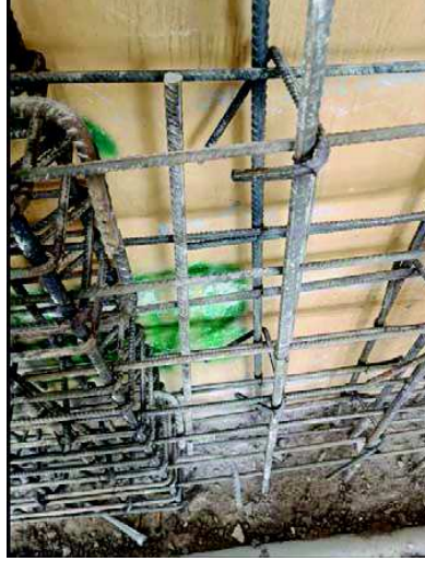
Şekil 2. a) Sıvası kaldırılmadan manto uygulaması, b)
