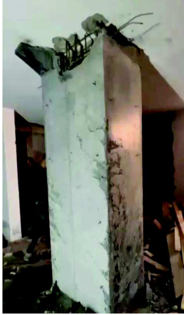
Şekil 4. Moment aktaramayan güçlendirme uygulaması
