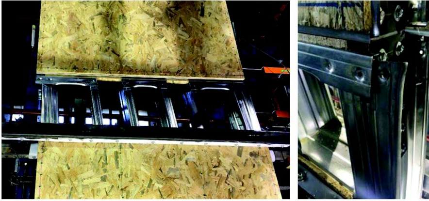
Şekil 7. Duvar bağlantı bölgelerinde oluşan hasarlar
