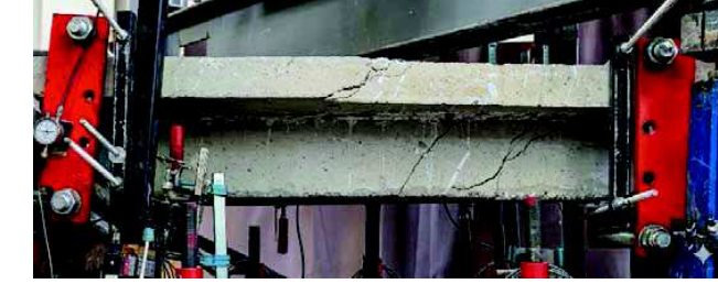
Şekil 9. Deney numunesinde çatlaklar
