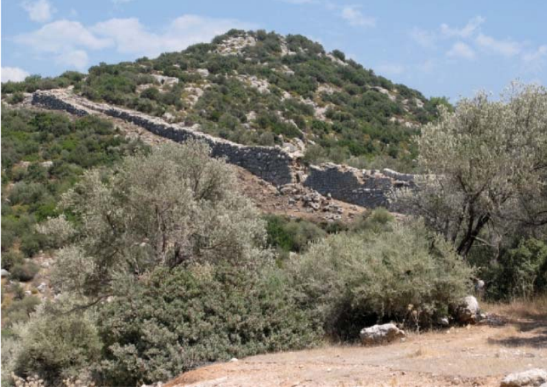
Şekil 4 - Delikkemer ters sifonu
