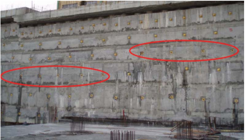
Şekil 9 - Projede kalıcı gözükmese de geçici ankraj detayıyla imal edilmiş ankrajlar.
